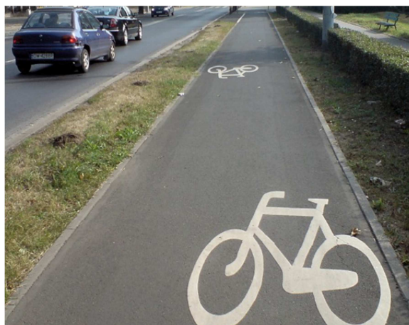
Rys. 2.10 Przykład drogi rowerowej odseparowanej od ruchu samochodów oraz pieszych [17]
