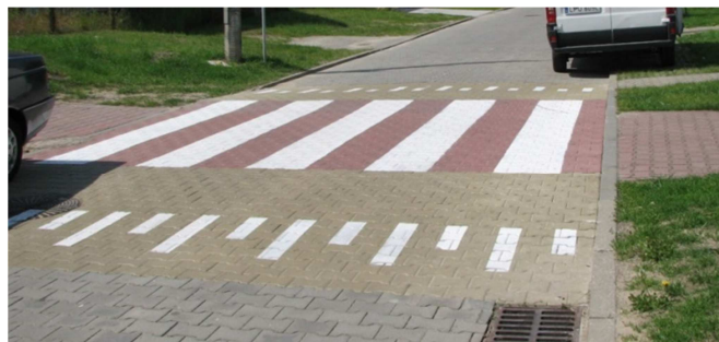
Rys. 2.21 Przykład zastosowania wyniesionej powierzchni przejścia dla pieszych
