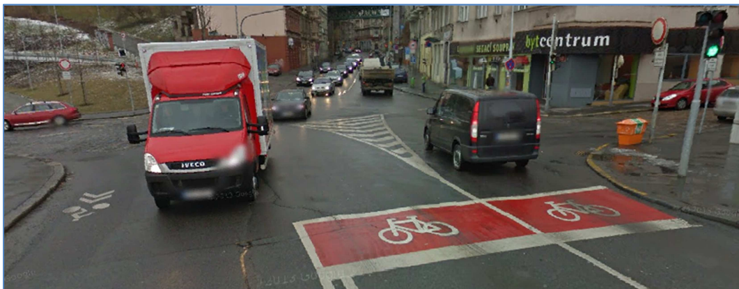
Rys. 2.6 Zastosowanie śluzy typu Ia na ulicy Husitskiej w Pradze
