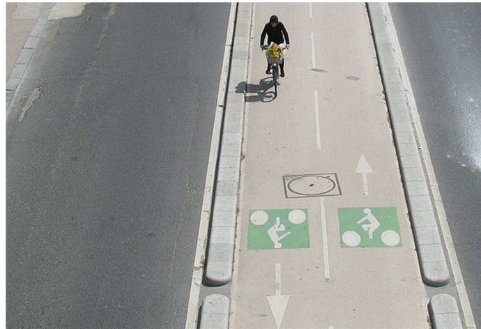
Rys. 2.24 Przykład zastosowania betonowych separatorów prefabrykowanych
