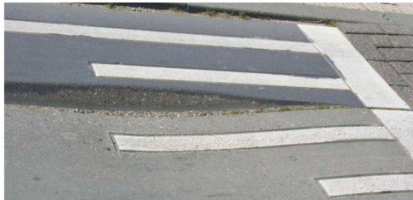
Rys. 2.18 Przykład zastosowania progu zwalniającego bez ograniczeń dla rowerzystów
