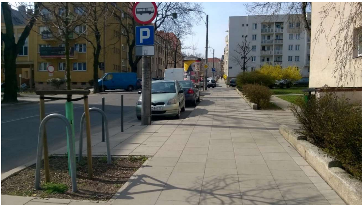
Chodnik w całości wykonany z jasnoszarych płyt betonowych 50 x 50 cm bez pasów kompensacyjnych.
