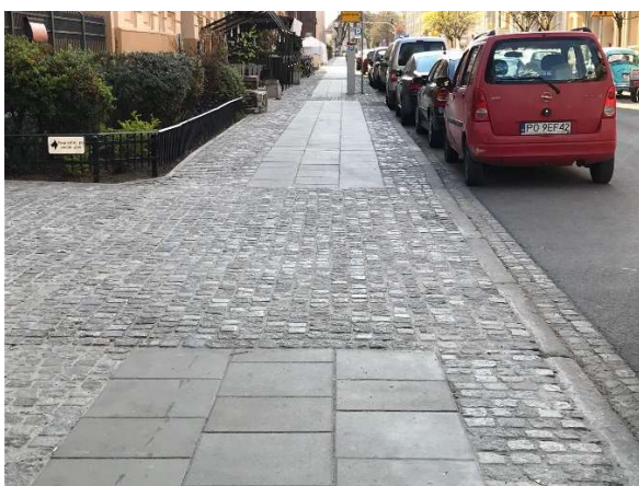
Zjazdy na posesje przerywające ciągłość chodnika, wykonane z kostki granitowej łupanej i kostki betonowej
