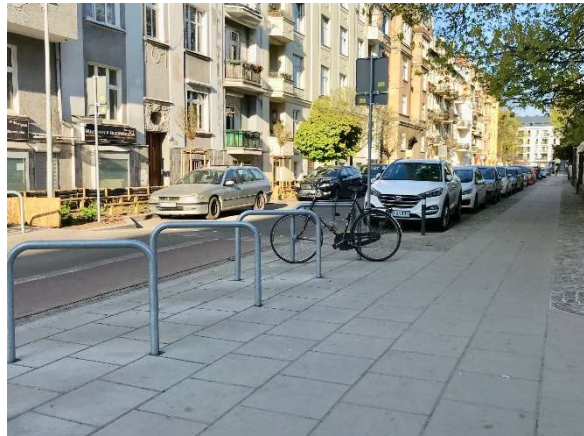
Poszerzenie w rejonie skrzyżowania („uszy Myszki Miki”) wykonane z nawierzchni głównego ciągu chodnikowego – jasnoszarych płyt betonowych 50 x 50 cm.
