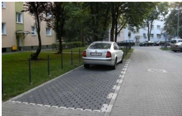
Miejsca postojowe wykonane z grafitowej, betonowej ekokostki i kostki typu kość
