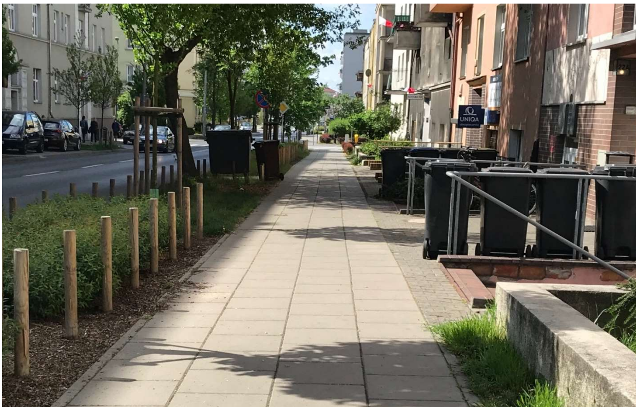
Pas kompensacyjny z kostki betonowej korygujący linię chodnika
