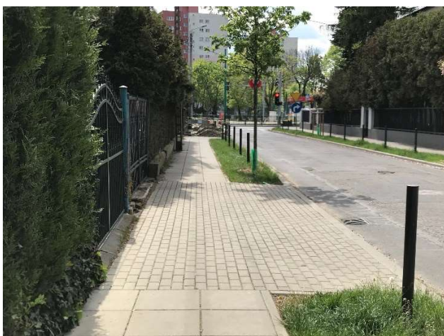
Zjazdy na posesje z kostki betonowej
