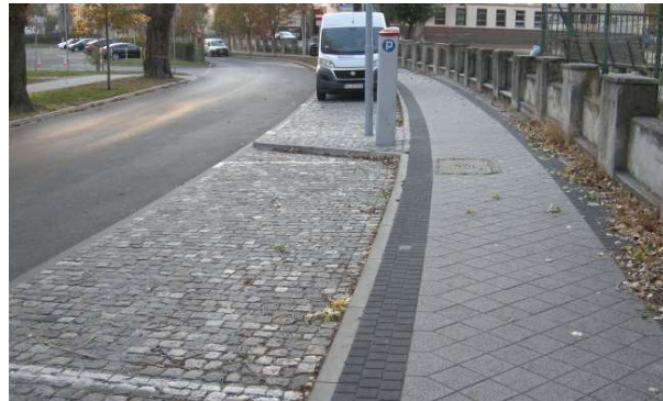
Miejsca postojowe zlokalizowane na jezdni, wzdłuż chodnika oraz w zatokach postojowych wyłożonych kostką rzędową
