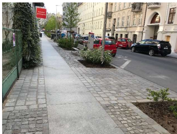
Zjazdy: przerwana ciągłość chodnika ze względu na ruch cięższych pojazdów oraz ciągłość nawierzchni chodnika na zjeździe
