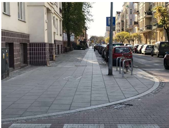
Poszerzenie w rejonie skrzyżowania („uszy Myszki Miki”) wykonane z nawierzchni głównego ciągu chodnikowego – jasnoszarych płyt betonowych 50 x 50 cm.
