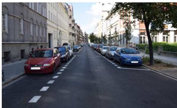
Miejsca postojowe zlokalizowane na jezdni, wzdłuż chodnika oraz w zatokach postojowych wyłożonych kostką rzędową
