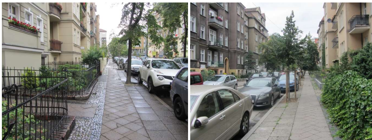
Ulica Poplińskich na Wildzie. Zachowany oryginalny chodnik: po stronie zachodniej z płytek 35x35 cm i półówkowych przy krawężdziach a po stronie wschodniej z płytek 25x25 cm oraz z płytek typu czapka biskupia (infuła) przy krawężdziach chodnika.
