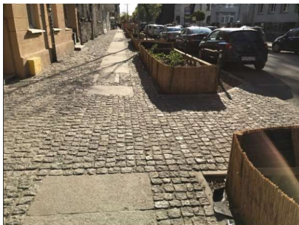
Zjazdy: przerwana ciągłość chodnika ze względu na ruch cięższych pojazdów oraz ciągłość nawierzchni chodnika na zjeździe
