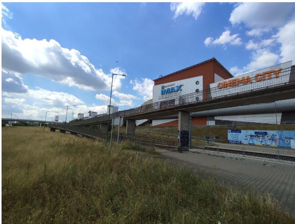
Etap II- modernizacja pochylni zlokalizowanej po południowej stronie wiaduktu 9 Maja przy PST Lechicka Plaza
