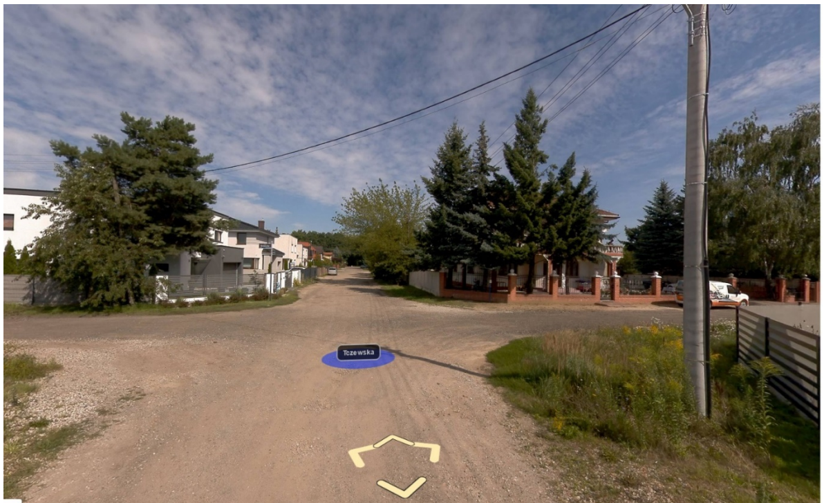
Fot.4 Widok na skrzyżowanie z ulicą Gniewską od strony południowej ulicy Tczewskiej. Widoczna nawierzchnia ulicy Gniewskiej z kruszywa oraz wierzchniej warstwy żużla.
