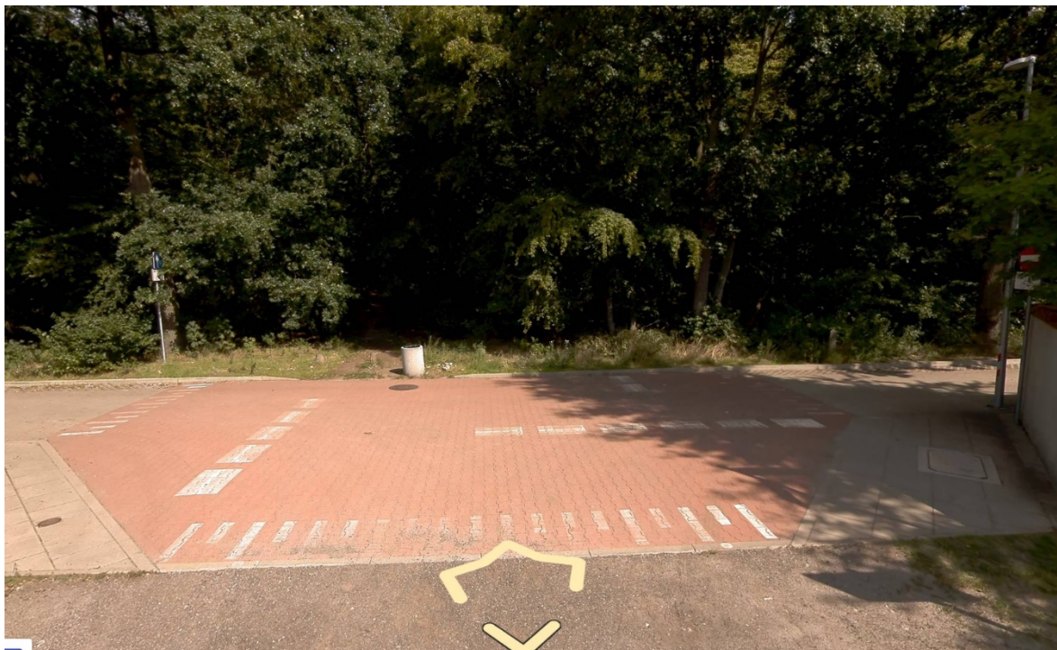
Fot.5 Widok na tarczę skrzyżowania z ulicą Polanowską od strony południowej ulicy Tczewskiej. Widoczny zatopiony opornik betonowy na krawędzi nawierzchni i chodników (miejsce dowiązania projektowanej nawierzchni w etapie 2). W tle widoczne oznakowanie pionowe (małe/mini) oraz oświetlenie drogowe dla ulicy Polanowskiej.
