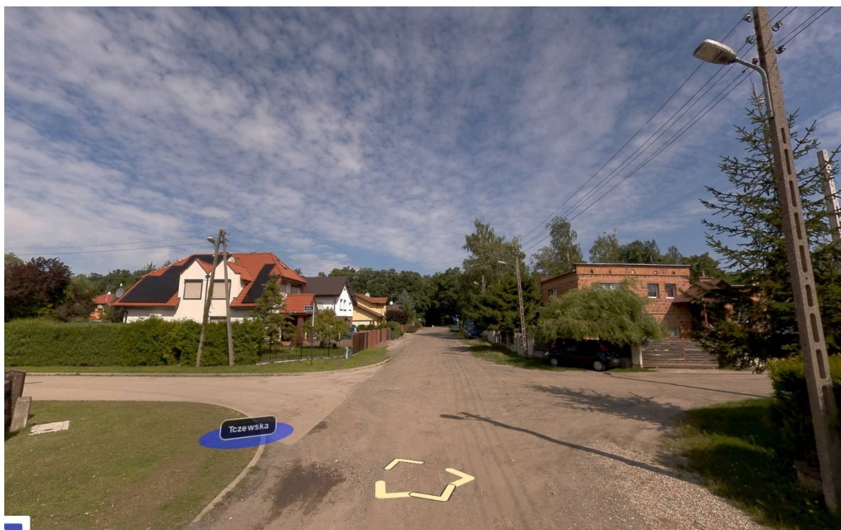
Fot.6 Widok na skrzyżowanie z ulicą Pucką od strony południowej ulicy Tczewskiej. Widoczna nawierzchnia ulicy Puckiej - strona wschodnia z kruszywa do wymiany oraz wyremontowana strona zachodnia z kostki betonowej z zagospodarowanymi poboczami zielenią niską.
