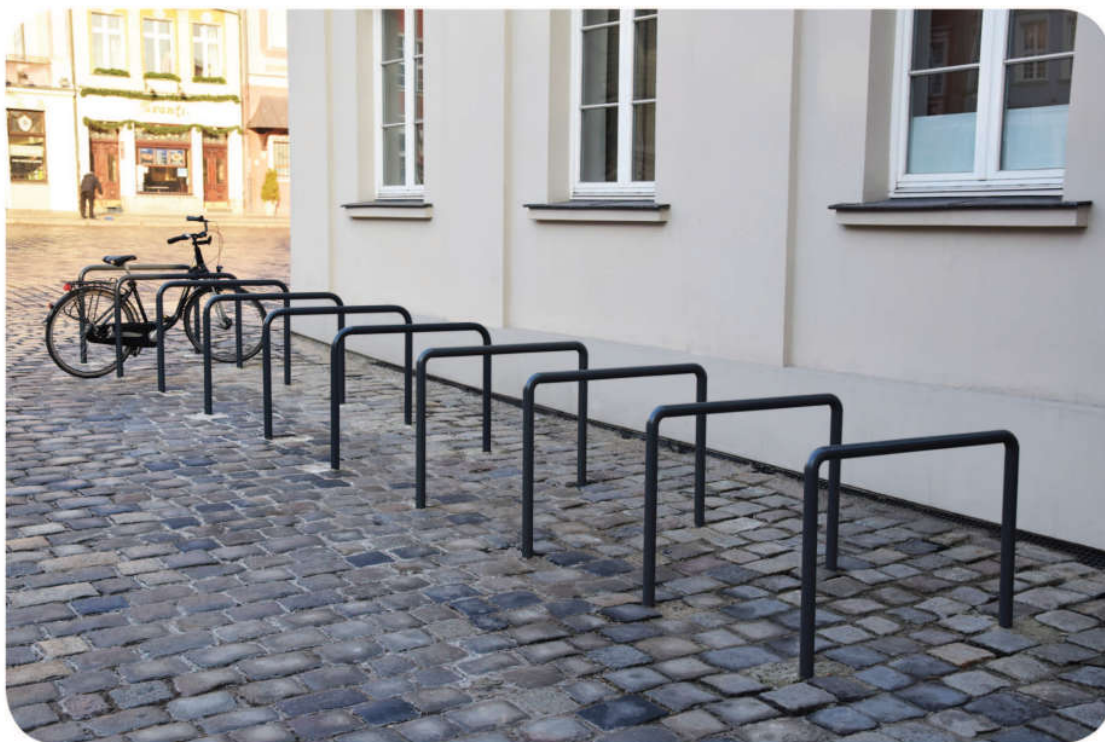
Fot. 2. Stojak rowerowy wys. 70 cm, długości 100 cm, średnica rur 4,8 cm, stal ocynkowana malowana proszkowo, kolor grafit (RAL 7043) półmatowy lub ocynk niemalowany ławka z oparciem i podłokietnikami niepołączona z gruntem – 1 szt. (typu LAW-06-CHO-UL)
