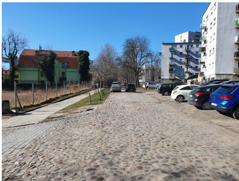
Fot. nr 5 Istniejąca jezdnia ul. Urbanowskiej wraz z chodnikiem
