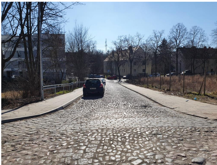
Fot. nr 2 Jezdnia oraz chodniki wzdłuż ul. Drzymały – od strony ul. Urbanowskiej
