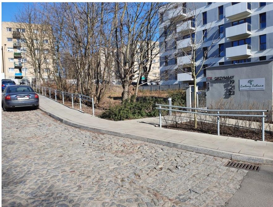
Fot. nr 4 Istniejący wyremontowany chodnik wzdłuż ul. Drzymały w postaci pochylni z poręczą
