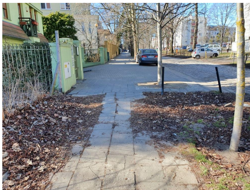
Fot. nr 7.1 Istniejąca nawierzchnia chodnika wzdłuż ul. Urbanowskiej w miejscu dowiązania się z przebudowywanym chodnikiem - widok od strony ul. Drzymały w stronę ul. Urbanowskiej
