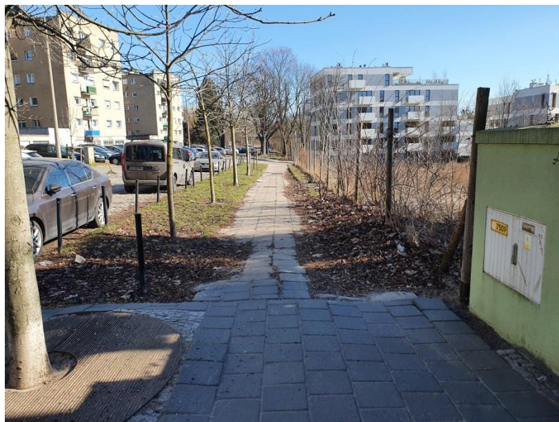
Fot. nr 7.2 Istniejąca nawierzchnia chodnika wzdłuż ul. Urbanowskiej w miejscu dowiązania się z przebudowywanym chodnikiem - widok od strony ul. Urbanowskiej w stronę ul. Drzymały
