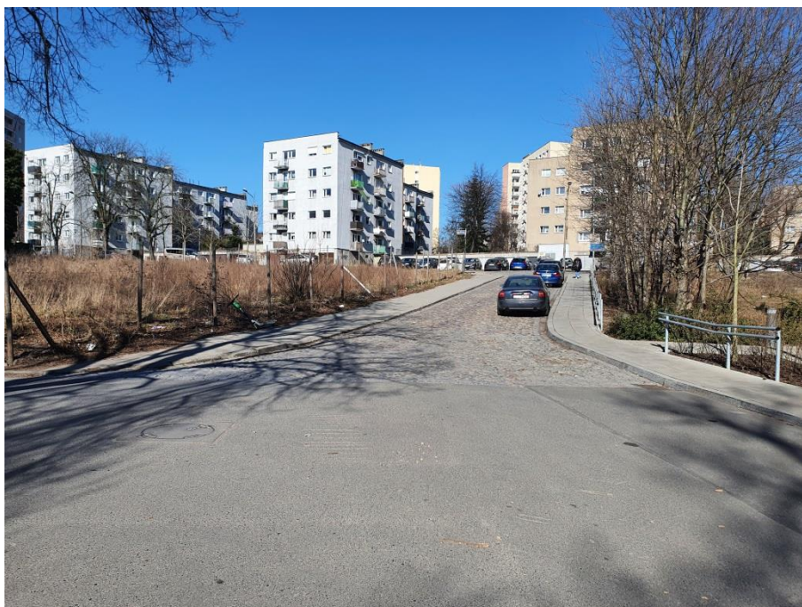
Fot. nr 1 Jezdnia oraz chodniki wzdłuż ul. Drzymały – od strony ul. Drzymały
