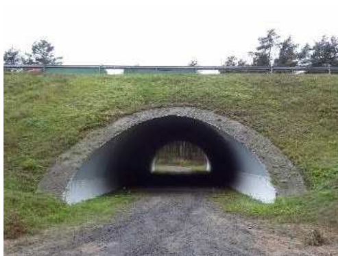
Rys. 3.266. Obiekt gruntowo-powłokowy o przekroju zamkniętym, stan fundamentu niewzbudzający zastrzeżeń. Nie stwierdzono osiadań konstrukcji, deformacji powłoki z blachy falistej i innych ewentualnych uszkodzeń spowodowanych złym stanem fundamentu
