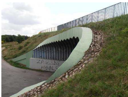
Rys. 3.82. Gzyms (wieniec betonowy) na krawędzi konstrukcji z blachy falistej bez uszkodzeń, w dobrym stanie technicznym
