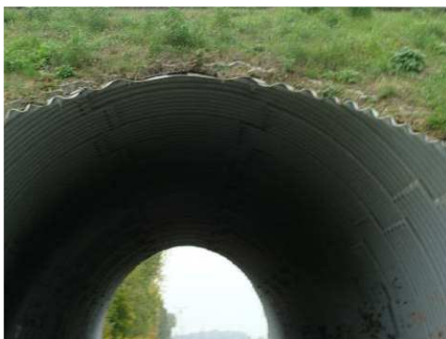
Rys. 3.84. Konstrukcja gruntowo-powłokowa, na której nie projektowano i nie wykonano gzymsu (wieńca betonowego)
