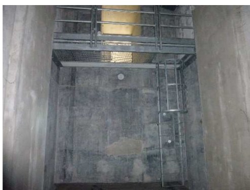
Rys. 3.385. Drabina i pomost rewizyjny bez uszkodzeń
