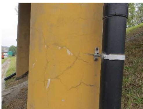
Rys. 3.283. Rysy skurczowe z białymi wyługowaniami na bocznych powierzchniach słupów filara
