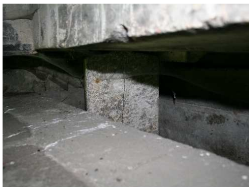
Rys. 3.231. Łożysko kamienne wahaczowe – widoczne pionowe pęknięcia/rysa pomiędzy przegubami. Uszkodzenie ma charakter przeciążeniowy
