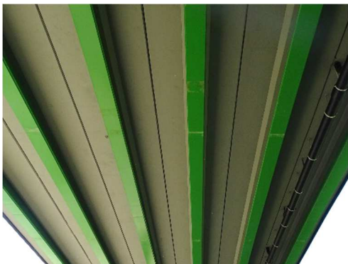
Rys. 3.129. Spodnia powierzchnia płyty pomostu przęsła wykonanego z belek typu VFT nie-wykazująca uszkodzeń
