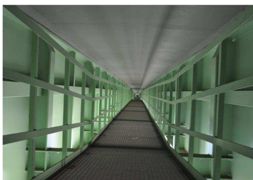
Rys. 3.386. Pomost rewizyjny bez uszkodzeń
