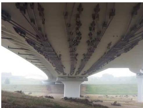
Rys. 3.350. Zakotwienia kabli sprężenia zewnętrznego w dobrym stanie technicznym, brak uszkodzeń
