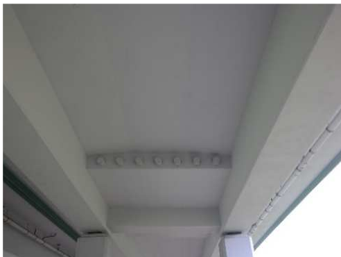
Rys. 3.349. Zakotwienia podłużnego sprężenia płyty pomostu w dobrym stanie technicznym, brak uszkodzeń
