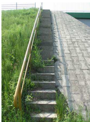
Rys. 3.2. Wegetacja roślin na schodach nieprzekraczająca 10% powierzchni
