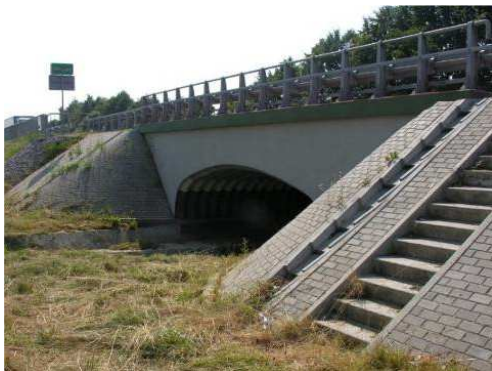
Rys. 3.83. Gzymsy na ścianie czołowej konstrukcji gruntowo-powłokowej bez uszkodzeń, w dobrym stanie technicznym
