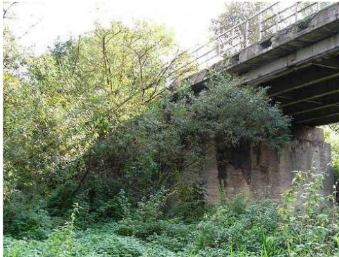
Rys. 3.4. Wegetacja roślin (drzew, krzewów) występująca na ponad 30% powierzchni nasypów, zagrażająca trwałości stożków i ich stateczności
