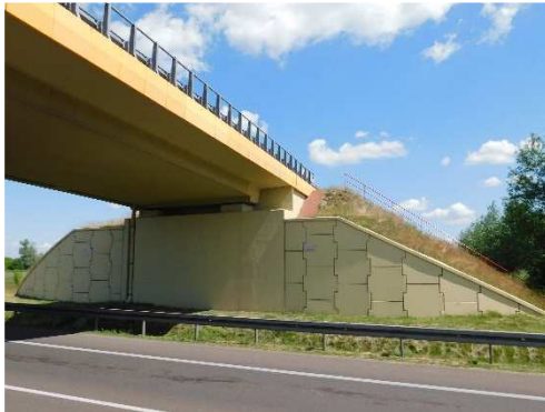
Rys. 3.260. Korpus przyczółka niewykazujący uszkodzeń
