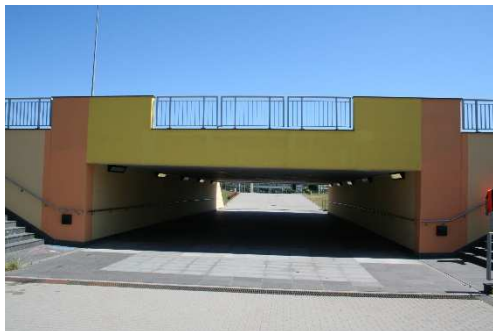
Rys. 3.26. Ściana czołowa przejścia podziemnego bez uszkodzeń
