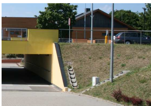
Rys. 3.65. System odwodnienia przejścia podziemnego bez zastrzeżeń
