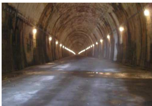
Rys. 3.43. Widoczne zastoiska wody na płycie dennej, brak przecieków przez strop i ściany obudowy tunelu
