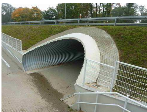
Rys. 3.6. Skarpa zasypki przejścia podziemnego wraz z umocnieniem bez uszkodzeń
