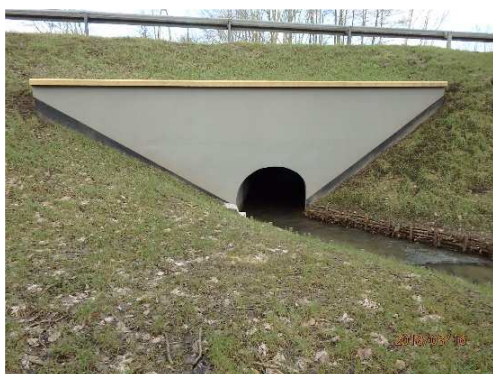
Rys. 4.78. Przepust sklepiony z głowicą w postaci ścianki czołowej z podwieszonymi skrzydłami bez uszkodzeń
