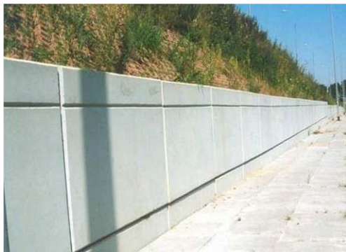
Rys. 5.30. Przemieszczenia poszczególnych elementów niewpływające na stateczność konstrukcji
