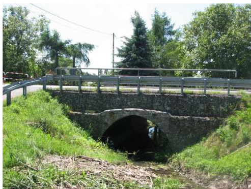
Rys. 4.75. Przepust o konstrukcji gruntowo-powłokowej z głowicą z gabionów bez uszkodzeń
