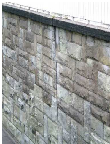
Rys. 5.49. Szczelina dylatacyjna bez uszkodzeń
