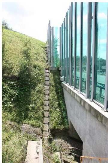
Rys. 5.46. Niewielkie zanieczyszczenia i wegetacja na ściekach skarpowych
