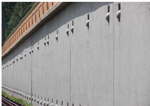
Rys. 5.13. Korpus o konstrukcji betonowej bez uszkodzeń
