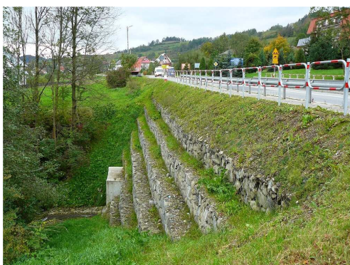
Rys. 5.36. Wegetacja roślin i niewielkie przemieszczenia koszy
