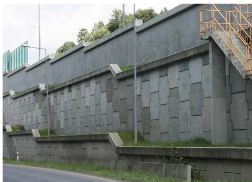
Rys. 5.55. Gzymsy na konstrukcji oporowej bez uszkodzeń
