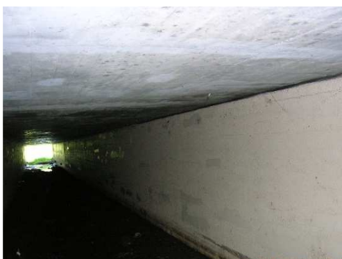
Rys. 4.46. Ściany boczne przepustu bez uszkodzeń. Występują niewielkie (do 5%) zanieczyszczenia obniżające estetykę
