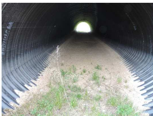
Rys. 4.61. Przepust „suchy”/przejście dla zwierząt o konstrukcji gruntowo-powłokowej bez uszkodzeń
