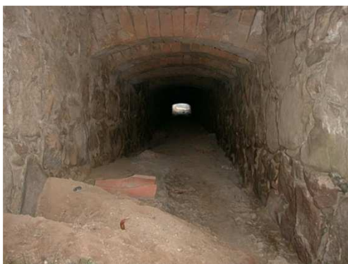
Rys. 4.47. Ściany przepustu kamiennego bez uszkodzeń, niewielka miejscowa korozja (fusz-czenie) materiału konstrukcyjnego
