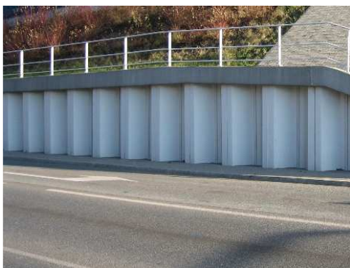
Rys. 5.39. Konstrukcja oporowa bez uszkodzeń
