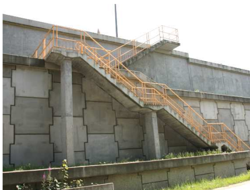
Rys. 5.56. Schody przy konstrukcji oporowej bez uszkodzeń
