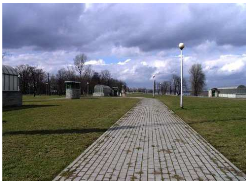
Rys. 3.88. Teren nad tunelem uporządkowany, dobrze utrzymany, bez uszkodzeń mających wpływ na trwałość i bezpieczeństwo konstrukcji
