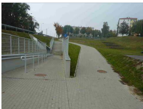
Rys. 3.23. Balustrady bez uszkodzeń
