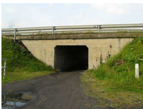
Rys. 3.4. Przemieszczenia i osiadanie gruntu skarpy powodujące odstąpienie ściany czołowej
