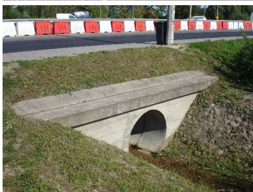
Rys. 4.25. Gzyms w dobrym stanie technicznym, bez uszkodzeń
