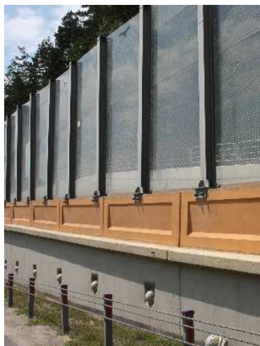
Rys. 5.64. Ekran przeciwhałasowy na konstrukcji oporowej bez uszkodzeń
