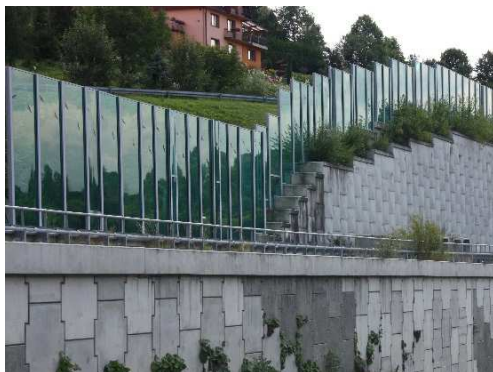
Rys. 5.63. Ekran przeciwhałasowy na konstrukcji oporowej bez uszkodzeń
