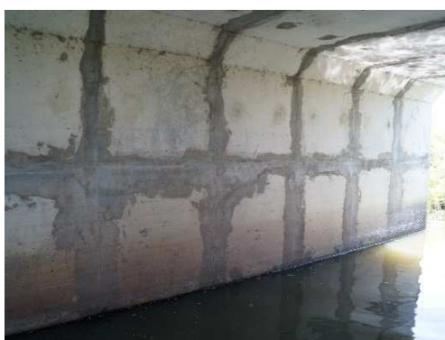
Rys. 4.64. Elementy ramowe prefabrykowane przepustu skrzynekowego dwudzielnego bez uszkodzeń. Lokalnie występują niewielkie zanieczyszczenia
