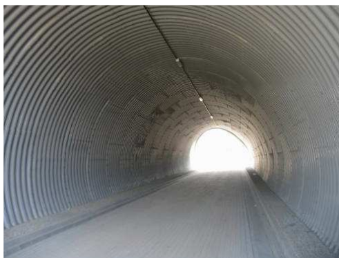
Rys. 3.10. Nawierzchnia jezdni bez uszkodzeń
