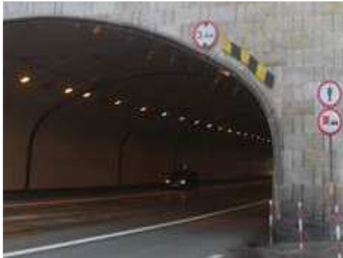
Rys. 3.71. Elementy oświetlenia w dobrym stanie technicznym i odpowiednio utrzymane
