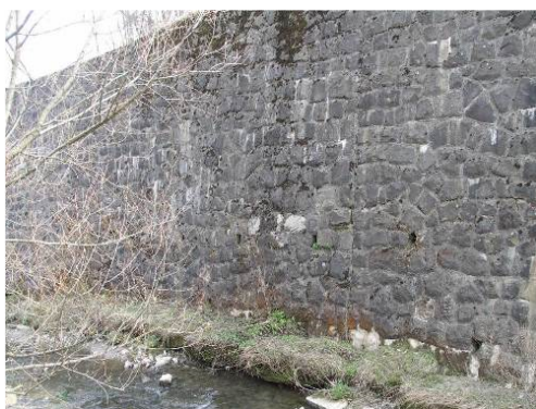
Rys. 5.21. Widoczne osady i wykwity pojawiające się w spoinach elementów kamiennych. Kamień częściowo porośnięty mchem
