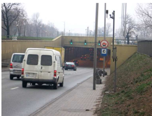
Rys. 3.5. Skarpy przy wjeździe do tunelu właściwie zabezpieczone i utrzymane
