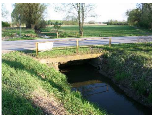
Rys. 4.20. Uszkodzenie malarskiej powłoki antykorozyjnej, lokalna korozja powierzchniowa, deformacja balustrady
