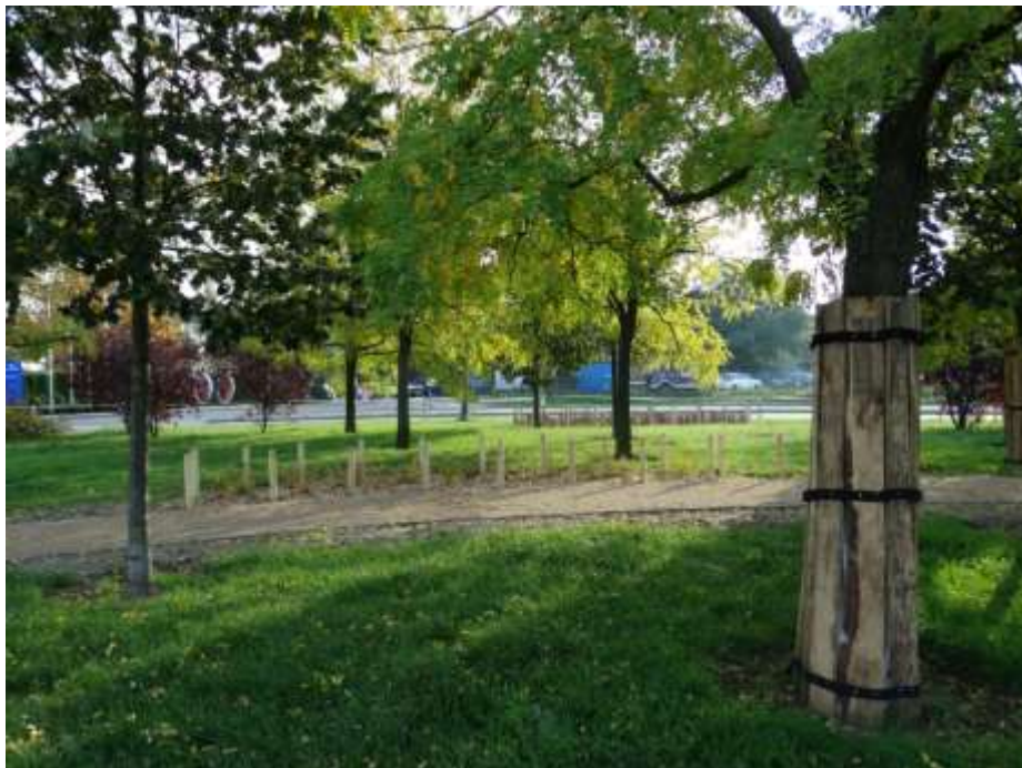
Rys. powyżej: Sposób zabezpieczenia drzew na terenie placu budowy
