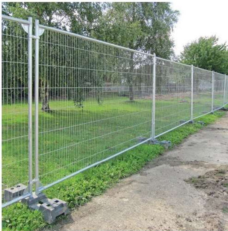
Rys. powyżej: materiał do zabezpieczenia terenu roboczego w trakcie robót
