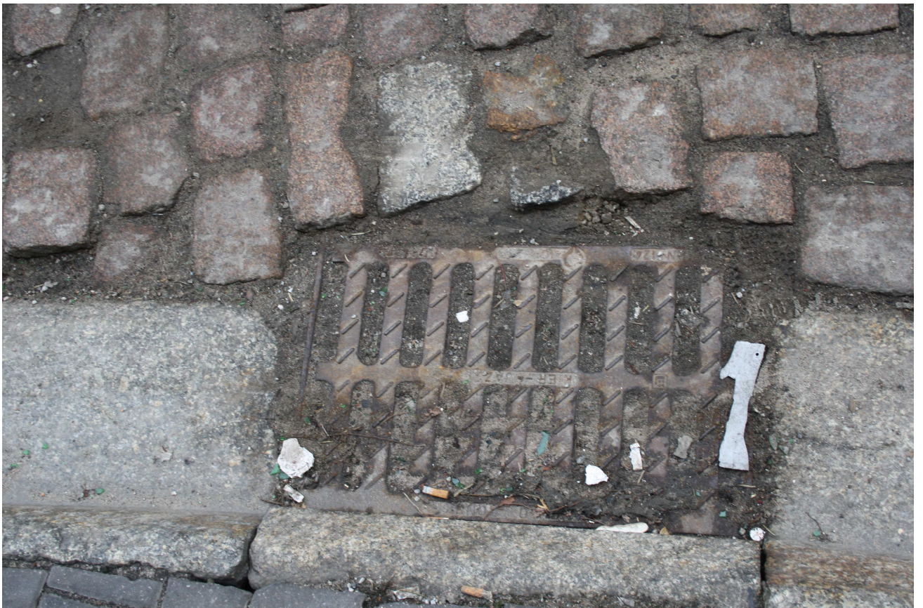
Ryc. 7. Stan wpustów deszczowych
