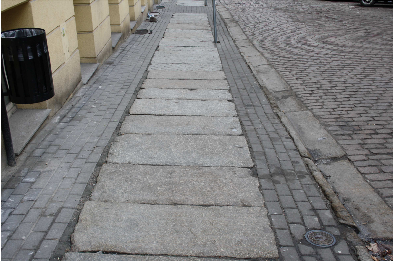
Ryc. 6. Widok na istniejący chodnik z płyt kamiennych i kostki brukowej betonowej (strona lewa)
