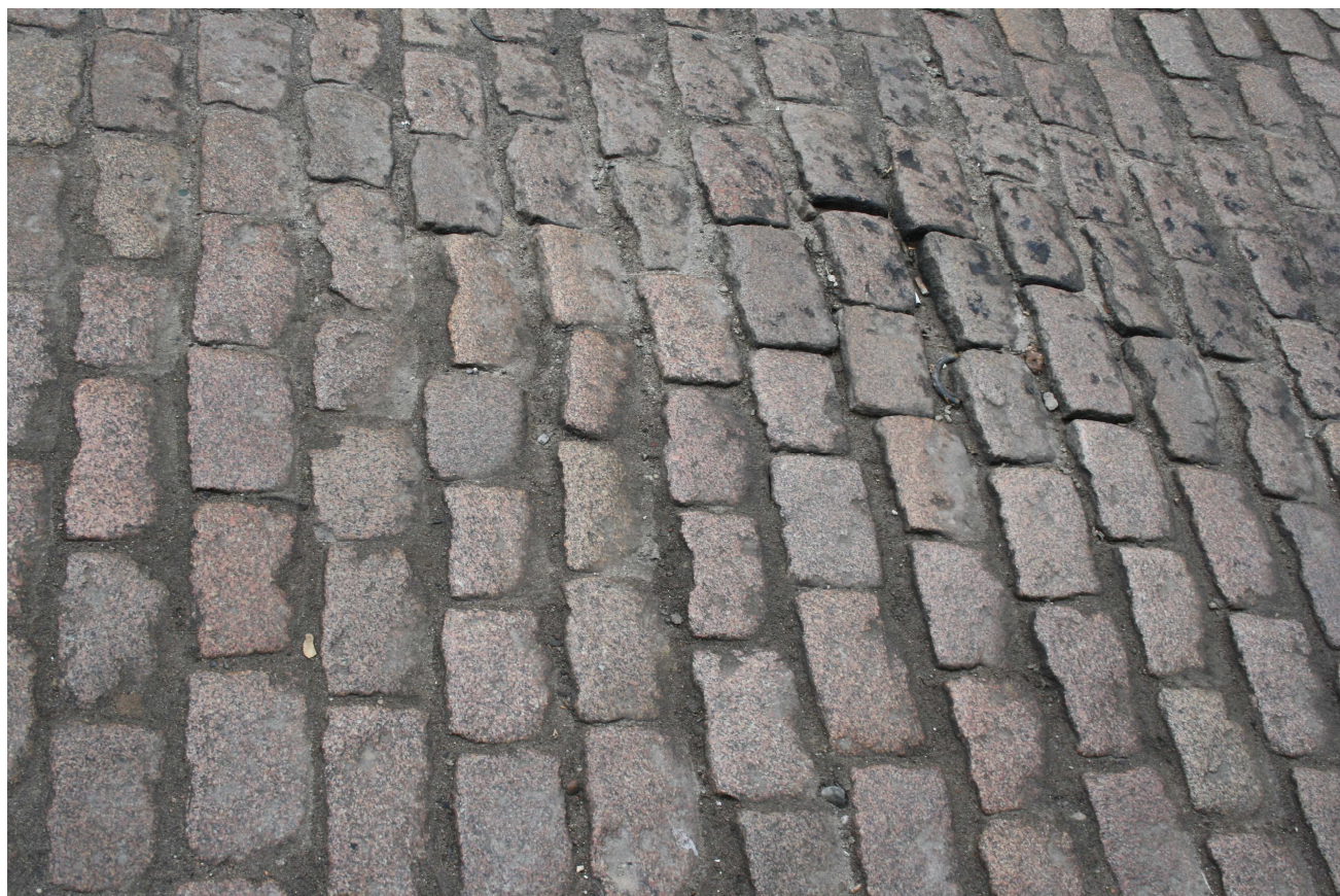
Ryc. 2. Stan nawierzchni jezdni ul. Ogrodowej
