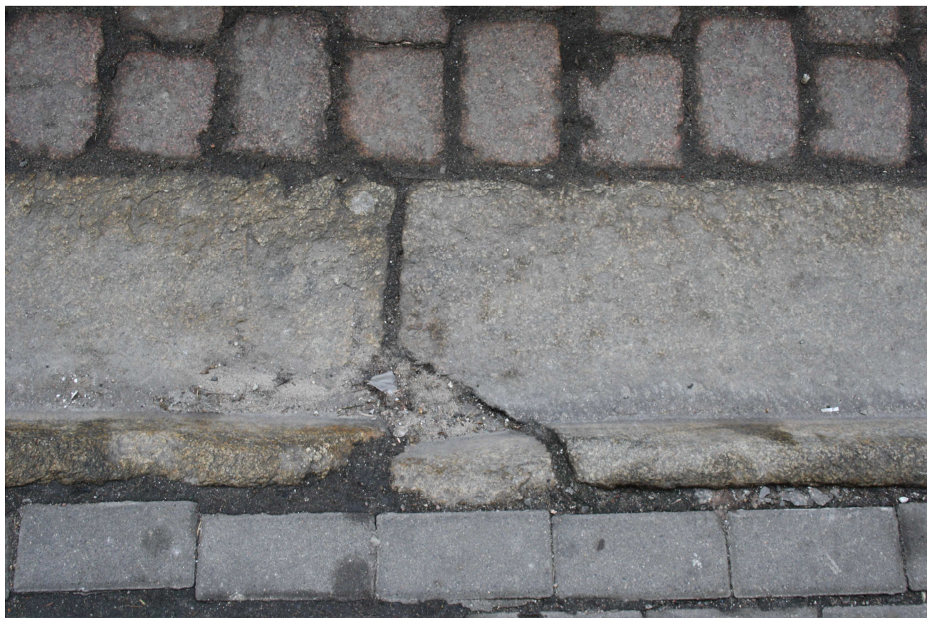
Ryc. 3. Stan krawężników ze ściekiem po stronie lewej
