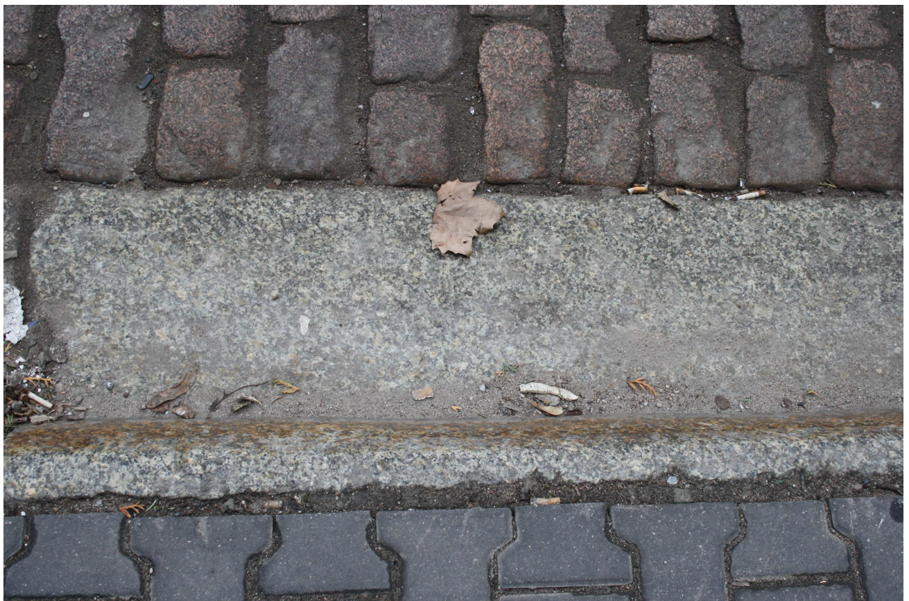
Ryc. 5. Stan krawężnika ze ściekiem po stronie prawej
