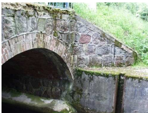
Rys. 5.35. Początki wegetacji roślin na głowicy wlotowej
