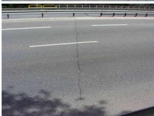
Rys. 3.13. Pęknięcie pojedyncze nawierzchni nad krawędzią płyty przejściowej
