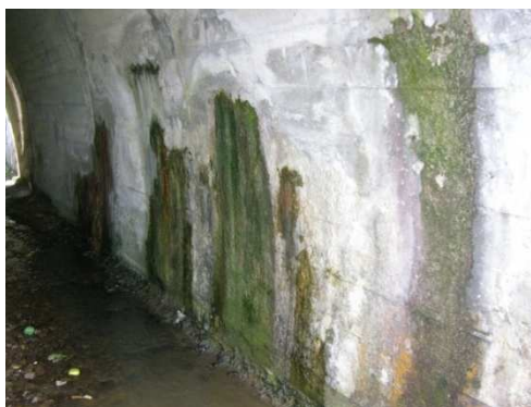
Rys. 5.16. Przecieki i zacieki wody przez ścianę przepustu świadczące o całkowitym uszkodzeniu izolacji
