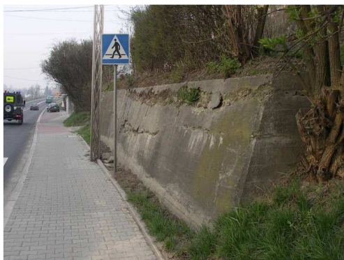
Rys. 6.14. Ubytki betonu sięgające głębokości 50 mm, występujące na połowie długości korpusu w miejscu przerwy w betonowaniu (powierzchnia ubytków ok. 10%). W korpusie występują też poziome rysy i pęknięcia. Przez rysy przedostaje się woda, przyspieszając korozję
