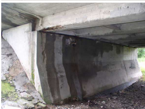
Rys. 3.115. Brak szczelności urządzenia dylatacyjnego - modułowego. Z poziomu pomostu nie stwierdzono uszkodzeń
