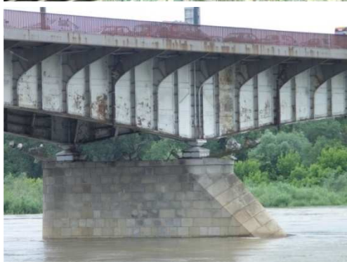
Rys. 3.92. Zniszczenie powłoki malarskiej i ogniska korozji powierzchniowej na ok. 10% powierzchni, niewpływające na nośność elementu
