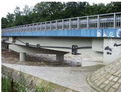
Rys. 3.149. Stan dewiatorów i zakotwień kabli sprężających niewzbudzający zastrzeżeń
