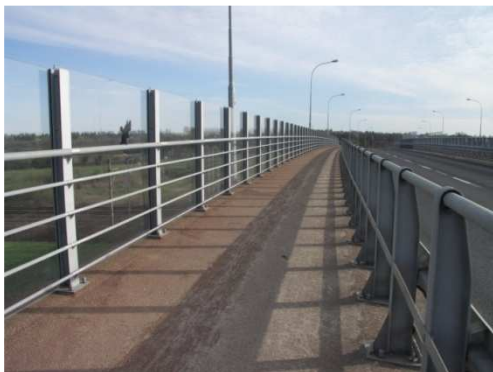
Rys. 3.146. Ekrany akustyczne w dobrym stanie
