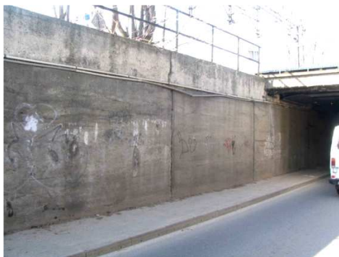
Rys. 6.44. Miejscowe uszkodzenie zamocowania przewodu telekomunikacyjnego i osłony z tworzywa sztucznego
