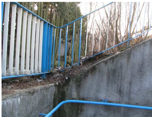
Rys. 4.33. Zanieczyszczenia, niewielkie (nieprzekraczające 5% powierzchni) przecieki wody oraz wykwity świadczące o korozji ługującej, występujące na ścianie oporowej
