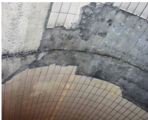
Rys. 4.39. Odpadanie elementów okładziny ze stropu tunelu (zagrożenie dla bezpieczeństwa użytkowników)
