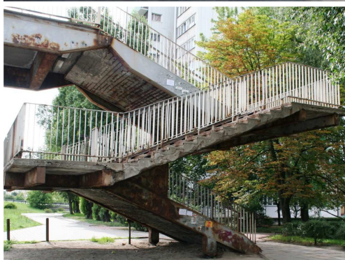
Rys. 3.165. Korozja i ubytki betonu płyty pomostu, silnie zaawansowana korozja stali konstrukcyjnej i zbrojeniowej
