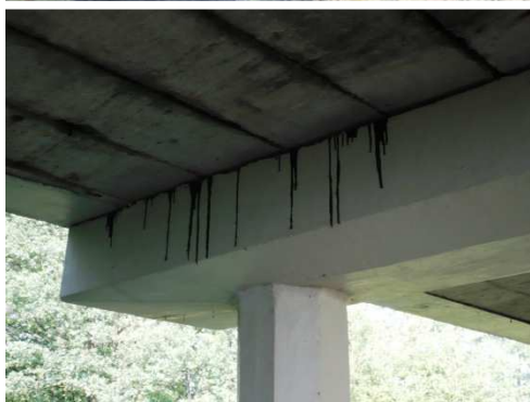
Rys. 3.107. Łożysko przekładkowe z widocznymi wyciekami bitumu
