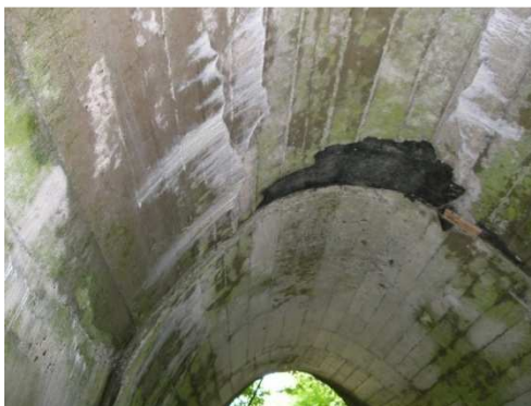
Rys. 5.19. Intensywne przecieki wody, wykwyty, ubytki betonu, początki wegetacji roślin na sklepieniu
