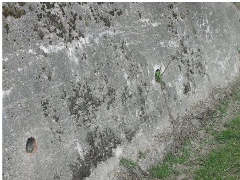
Rys. 6.30. Zanieczyszczone przewody z ceramicznych rurek drenarskich
