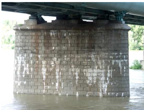
Rys. 3.122. Osady i wykwyty świadczące o korozji ługującej betonu
