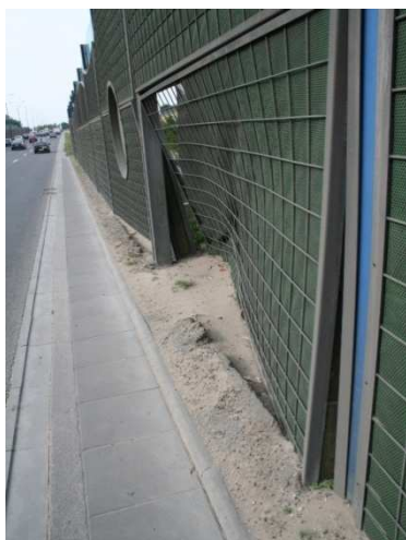
Rys. 3.148. Uszkodzony panel ekranu akustycznego
