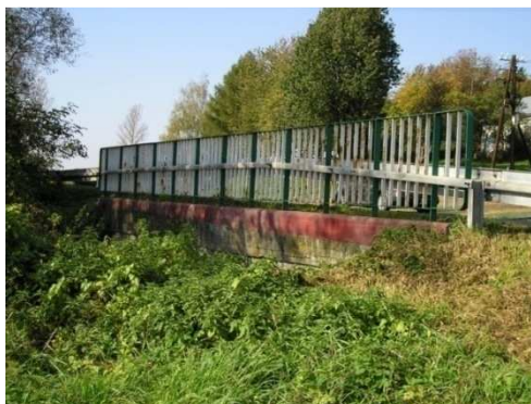
Rys. 5.8. Zniszczenie powłoki antykorozyjnej i początki korozji balustrady nad przepustem
