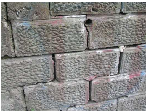
Rys. 6.22. Wypłukanie spoin elementów konstrukcji oporowej
