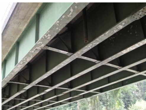
Rys. 3.91. Uszkodzenie zabezpieczenia antykorozyjnego, złuszczenie powłoki malarskiej na ok. 10% powierzchni dźwigarów
