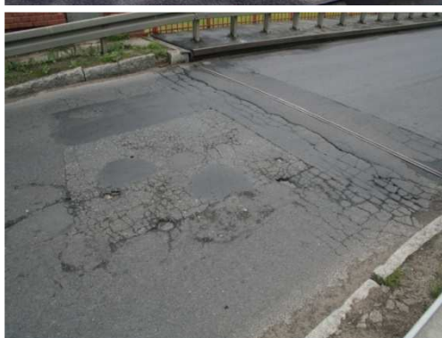
Rys. 3.14. Pęknięcia siatkowe, ubytki, obniżenie nawierzchni na dojeździe o ok. 25 mm i zanieczyszczenie jezdni przy krawężnikach
