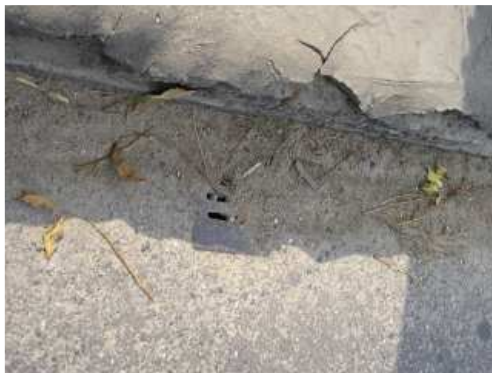
Rys. 3.15. Zanieczyszczenia nawierzchni jezdni przy krawężniku
