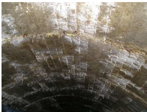
Rys. 4.43. Rozległe przecieki świadczące o nieskutecznej izolacji
