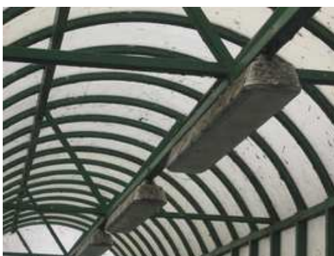
Rys. 4.48. Zanieczyszczenia elementów oświetlenia
