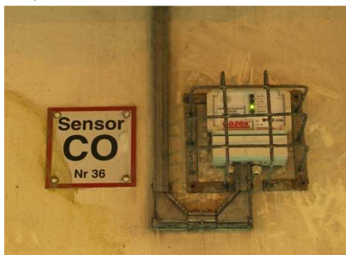
Rys. 4.56. Odpowiednio zabezpieczony i oznakowany czujnik tlenu węgla
