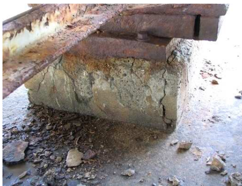
Rys. 3.127. Korozja betonu, rysy, pęknięcie i ubytki betonu ciosu podłożyskowego na filarze
