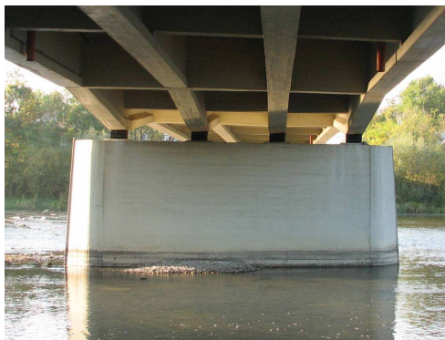
Rys. 3.121. Filar bez uszkodzeń
