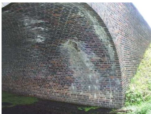
Rys. 3.98. Zacieki, osady i wykwyty na powierzchni sklepienia świadczące o korozji cegieł i ich spoin
