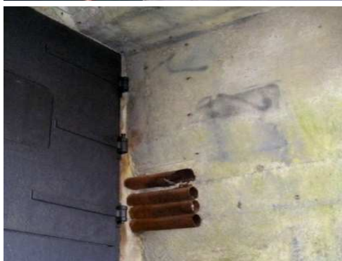
Rys. 4.64. Pozostałość po urządzeniach obcych, wskazany demontaż elementów
