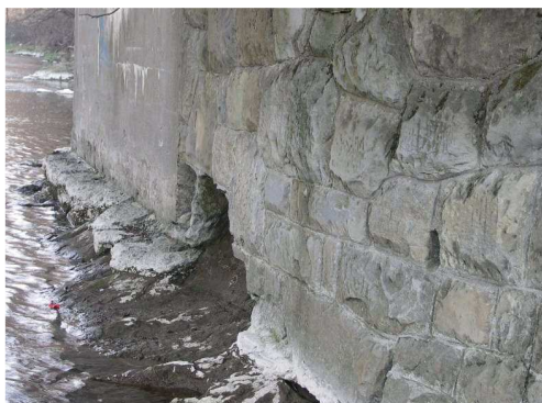
Rys. 6.19. Ubytki elementów korpusu na skutek podmycia
