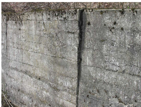
Rys. 6.12. Dokładne oględziny konstrukcji pozwalające stwierdzić, że przemieszczenie wystąpiło wiele lat temu i od tamtej chwili położenie korpusu się nie zmienia. W związku z tym można uznać, że nie ma zagrożenia dla stateczności konstrukcji
