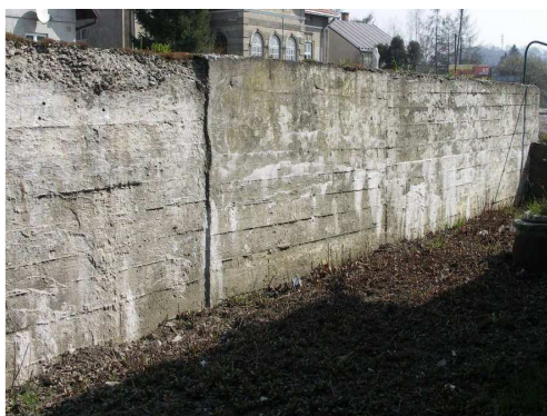
Rys. 6.15. Widoczne ubytki i korozja betonu. W wielu miejscach beton wykazuje oznaki zniszczenia struktury
