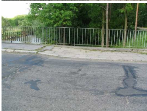
Rys. 3.12. Nawierzchnia na dojazdach obniżona o ok. 50 mm, powodująca zwiększone oddziaływania dynamiczne na konstrukcję i przyspieszoną degradację urządzenia dylatacyjnego. Występują również zastoiska wody i spękania asfaltu
