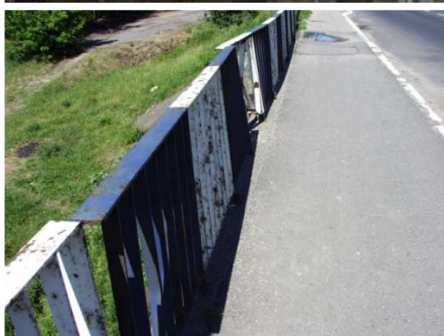
Rys. 3.38. Deformacja i przemieszczenie balustrady o ok. 20 cm, na odcinku ok. 5 m; deformacja 6 szczebli. W dwóch miejscach nastąpiła utrata ciągłości balustrady, uszkodzeniu uległo zamocowanie 3 słupków
