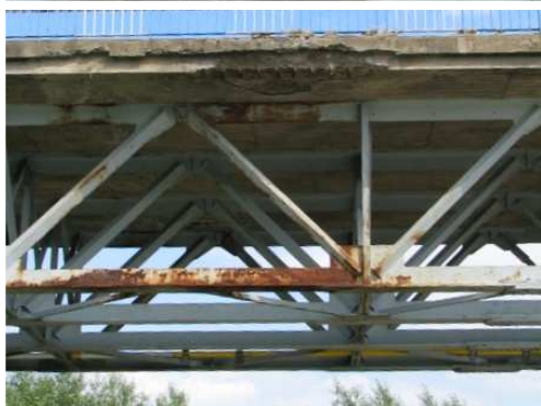
Rys. 3.93. Korozja pasa dolnego dźwigara kratownicowego - korozja powierzchniowa. Osłabienie przekroju szacuje się na poniżej 5%
