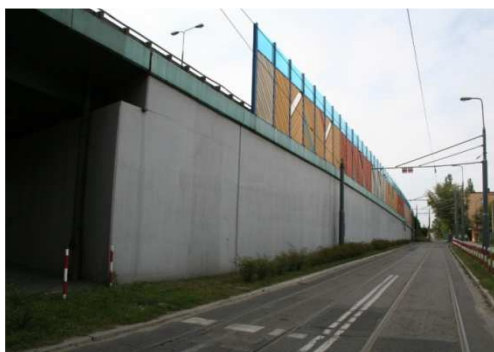
Rys. 3.143. Konstrukcja oporowa przyległa do przyczółka w bardzo dobrym stanie
