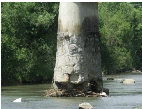
Rys. 3.123. Ubytki korpusu filara mające wpływ na jego bezpieczeństwo
