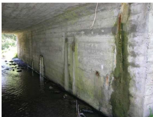
Rys. 5.21. Widoczne przecieki, korozja betonu (łuszczenie), wegetacja roślin (mchu) na ścianie przepustu ramownicowego
