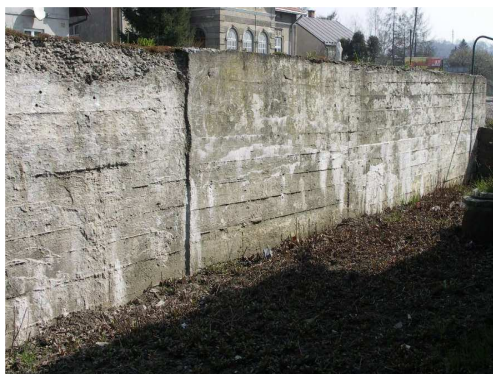
Rys. 6.34. Korozja ługująca świadcząca o braku skutecznej izolacji
