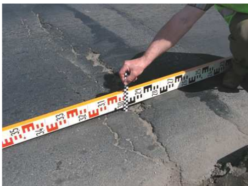
Rys. 3.111. Nierówności progowe (przekraczające 10 mm), rysy i ubytki asfaltu nad szczeliną dylatacyjną. Nie stwierdzono przecieków
