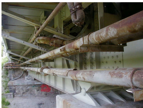
Rys. 3.157. Zniszczenie zabezpieczeń antykorozyjnych i korozja urządzeń obcych Kod uszkodzenia: AS, KS
