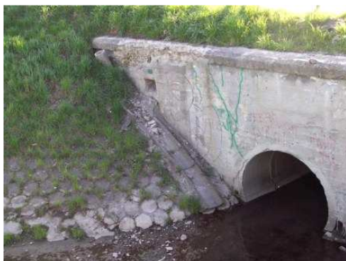
Rys. 5.36. Ubytki betonu występujące na głowicy
