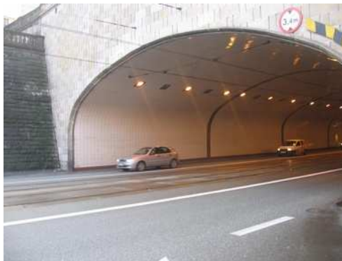
Rys. 4.36. Okładzina ścian i sklepienia tunelu w bardzo dobrym stanie technicznym
