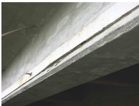
Rys. 3.87. Utrata połączenia klejowego pomiędzy dźwigarem żelbetowym a wzmacniającym go płaskownikiem stalowym
