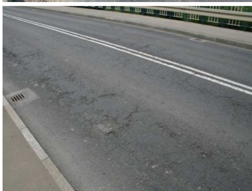
Rys. 3.18. Pęknięcia siatkowe z wykruszeniami występujące na ok. 20% powierzchni jezdni, miejscowe ubytki o wymiarach mniejszych niż 0.1 x 0.1 m
