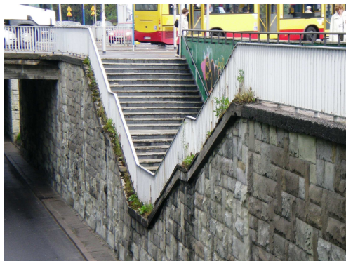
Rys. 6.40. Zanieczyszczenia i wegetacja roślin na gzymsie
