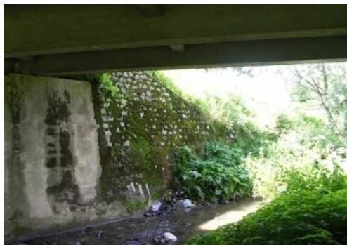
Rys. 3.144. Konstrukcja oporowa zawilgoconą (występują przecieki) i pokrytą roślinnością
