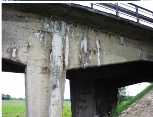
Rys. 3.78. Przecieki wody, osady i wykwyty świadczące o zaawansowanej korozji betonu, korozja zbrojenia – strzemion
