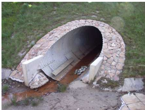
Rys. 5.37. Niewielkie podmycia i przemieszczenia fragmentów głowicy
