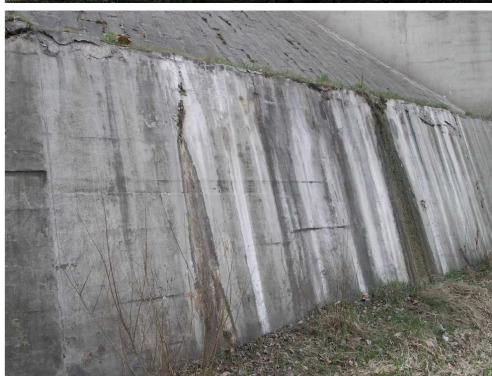
Rys. 6.16. Przecieki wody, osady na 50% powierzchni, miejscowe zniszczenie struktury materiału
