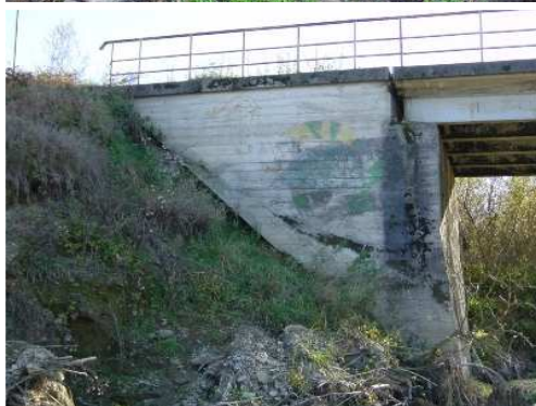
Rys. 3.4. Ubytki materiału i osunięcie skarpy stwarzające zagrożenie dla trwałości i stateczności całego przyczółka
