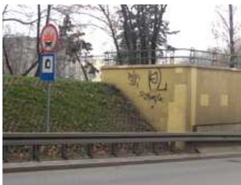
Rys. 4.1. Skarpy przy wjeździe do tunelu właściwie zabezpieczone i utrzymane
