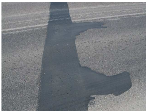
Rys. 3.112. Nierówności progowe i deformacja zalewki bitumicznej o głębokości ponad 10 mm
