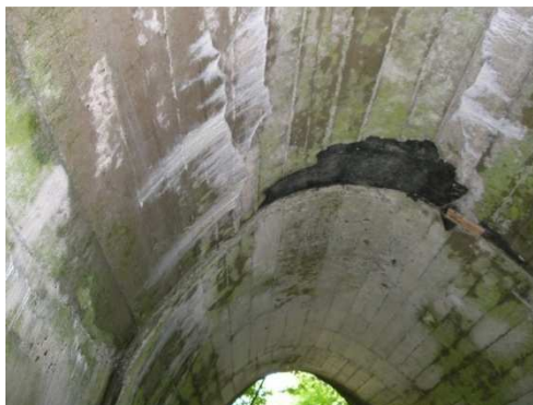
Rys. 5.15. Przecieki, zacieki oraz korozja betonu sklepienia świadczące o całkowitym uszkodzeniu izolacji przepustu
