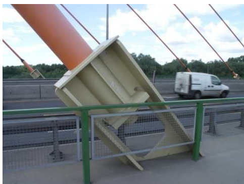
Rys. 3.150. Zakotwienie wanty w dobrym stanie
