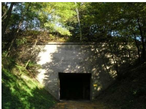
Rys. 4.60. Bujna wegetacja roślin na terenie nad tunelem zagrażająca jego trwałości
