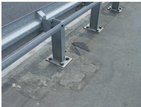
Rys. 3.20. Uszkodzenie izolacji-nawierzchni bitumicznej. Powierzchnia uszkodzenia nie przekracza 2% powierzchni chodnika
