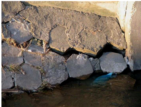
Rys. 5.40. Podmycie umocnienia skarpy cieką i przemieszczenie elementów wzmacniających skarpe
