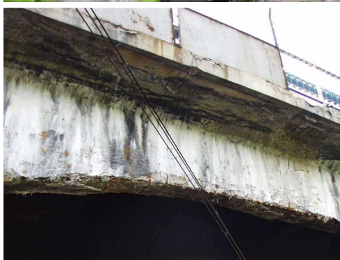
Rys. 3.79. Osady, wykwyty i ubytki betonu, korozja zbrojenia
