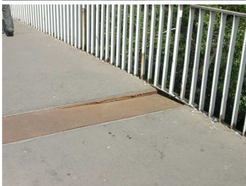
Rys. 3.114. Przemieszczenie (obniżenie) przekrycia z blachy stalowego urządzenia dylatacyjnego - ponad 10 mm
