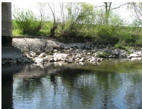
Rys. 3.136. Podmycie umocnień koryta rzeki. Brak odpowiednich umocnień może spowodować podmycie przyczółka
