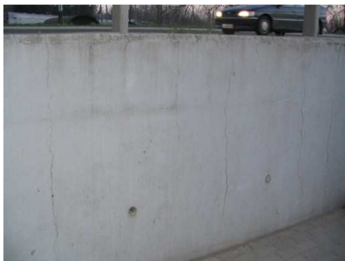
Rys. 6.10. Rysy o rozwartości ok. 0.5 mm w rozstawie ok. 2 m; brak wypełnienia otworu po ściąganiu deskowania
