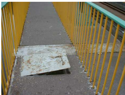
Rys. 7.2. Uszkodzenie pokrywy kanału kablowego stwarzające zagrożenie dla pieszych
