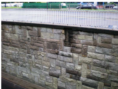
Rys. 6.33. Miejscowe przecieki wody świadczące o nieskutecznej izolacji
