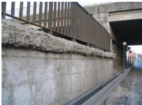
Rys. 6.41. Gzyms zniszczony, ubytki betonu, zacieki, osady
