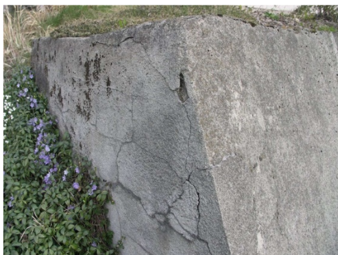
Rys. 6.11. Miejscowe zniszczenie struktury materiału
