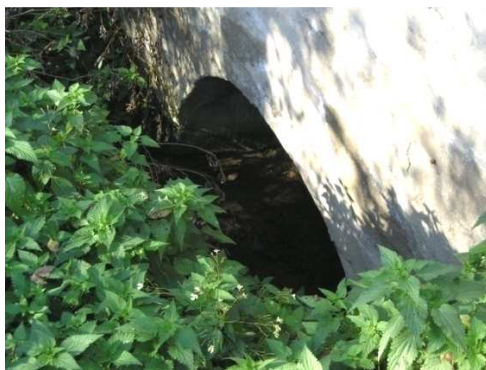
Rys. 5.41. Wegetacja roślin zmniejszająca przekrój koryta cieką. Roślinność blokuje przepływ wody
