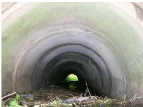
Rys. 5.25. Zanieczyszczenia przewodu od 20 do 30% powierzchni przekroju
