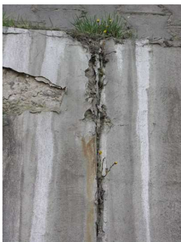
Rys. 6.37. Widoczne ubytki i korozja betonu, rdzawe zacieki oraz wegetacja roślin
