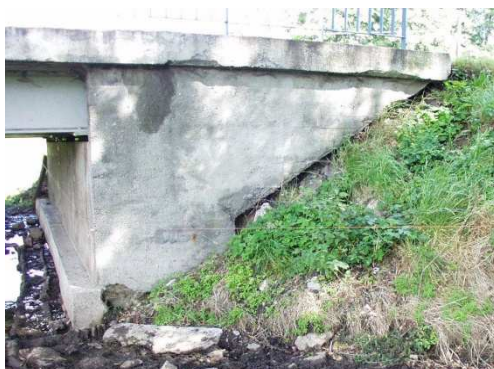
Rys. 3.117. Zacieki i korozja betonu skrzydła. Odsłonięte skrzydło zagraża stateczności i trwałości przyczółka
