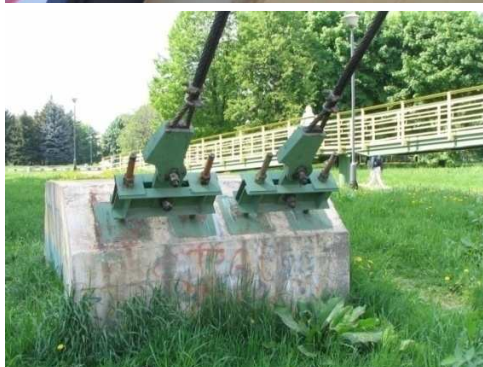
Rys. 3.152. Niewielka, nieprzekraczająca 5% powierzchni korozja elementów stalowych zakotwienia cięgien, rysy skurczowe na betonowym bloku kotwiącym o rozwarości do 0.5 mm
