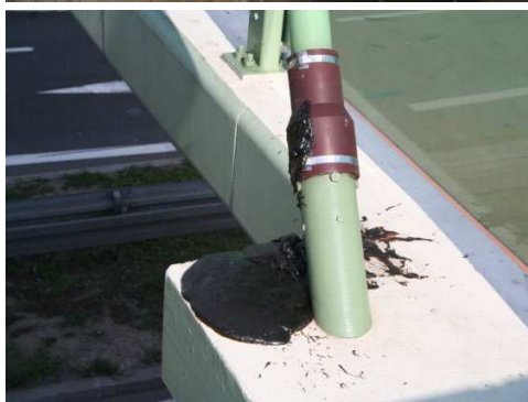
Rys. 3.155. Pęknięcie osłony kabla oraz wyciek materiału wypełniającego osłonę
