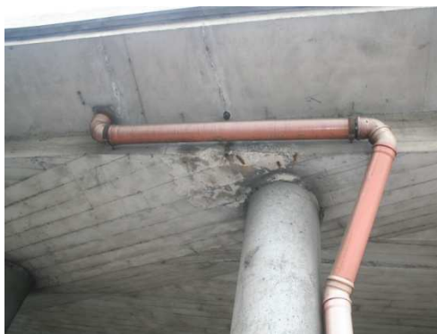
Rys. 3.55. Lokalne przecieki w sąsiedztwie słupa podpory
