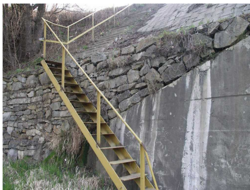
Rys. 6.43. Brak przeciągu balustrady oraz miejscowe uszkodzenie powłoki antykorozyjnej
