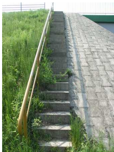
Rys. 3.8. Wegetacja roślin na schodach nieprzekraczająca 10% powierzchni
