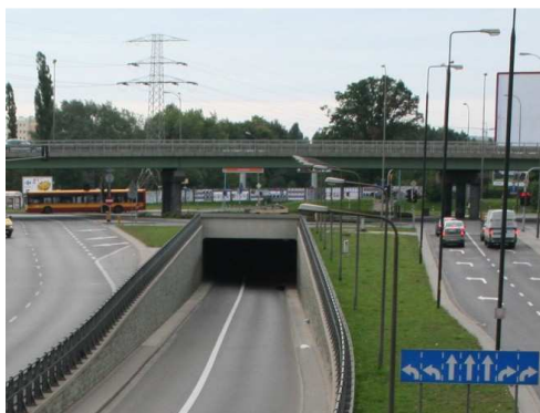
Rys. 4.58. Teren nad tunelem bez uszkodzeń mających wpływ na trwałość i bezpieczeństwo konstrukcji
