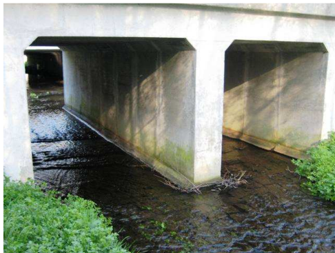
Rys. 5.33. Niewielkie zanieczyszczenia, początki wegetacji roślin
