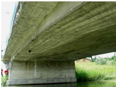
Rys. 3.76. Osady, wykwity, niewielka korozja i ubytki betonu na wspornikach pochodnikowych, lokalnie ubytki betonu i korozja strzemion
