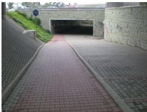
Rys. 4.53. Pochylnia w dobrym stanie - bez uszkodzeń i zanieczyszczeń
