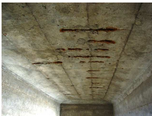
Rys. 3.60. Ubytki betonu i korozja zbrojenia na ok. 5% powierzchni płyty pomostu
