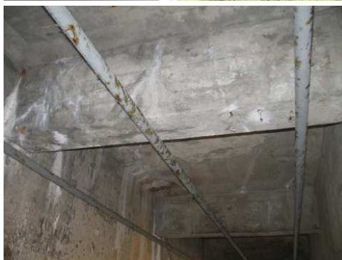
Rys. 3.154. Miejscowa korozja cięgien sprężających, zniszczenie powłoki antykorozyjnej
