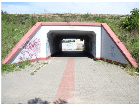
Rys. 4.59. Teren nad przejściem podziemnym wymagający uporządkowania i poprawy estetyki
