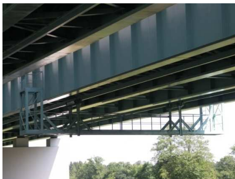
Rys. 3.170. Wózek rewizyjny w bardzo dobrym stanie
