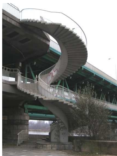
Rys. 3.163. Niewielkie, miejscowe ubytki powłoki malarskiej, graffiti
