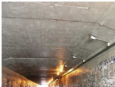
Rys. 4.23. Strop przejścia podziemnego w dobrym stanie. Występują jedynie niewielkie, miejscowe zanieczyszczenia
