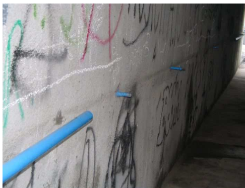
Rys. 4.15. Brak poręczy balustrady
