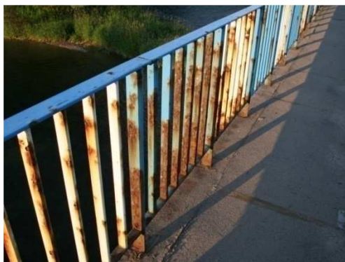
Rys. 3.31. Zniszczenie zabezpieczeń antykorozyjnych oraz zaawansowana korozja szczelin i słupków balustrady
