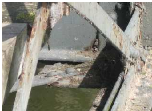
Rys. 3.90. Zanieczyszczenie węzła w moście kratownicowym
