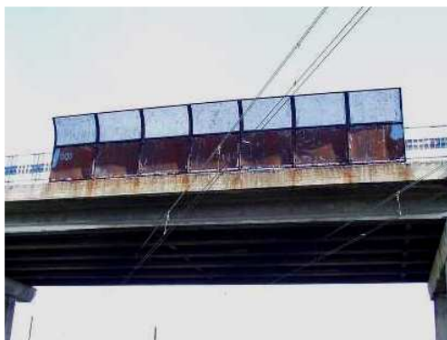
Rys. 3.32. Silna korozja osłony przeciwpożarzeniowej, perforacja elementu
