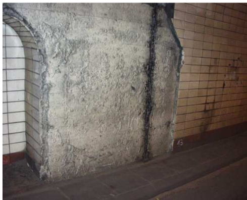
Rys. 4.38. Odpadanie elementów okładziny ze ścian tunelu
