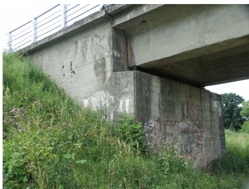
Rys. 3.116. Zanieczyszczenia (graffiti), osady i wykwyty
