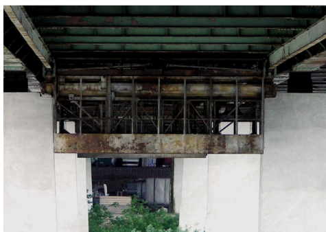
Rys. 3.171. Zniszczenie powłoki antykorozyjnej i korozja wózka rewizyjnego
