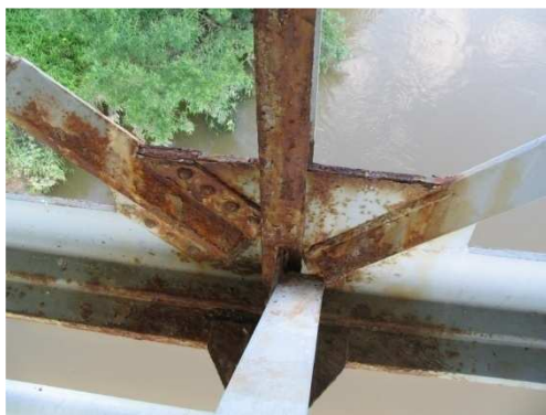
Rys. 3.94. Korozja węzła dźwigara kratownicowego. Osłabienie spowodowane ubytkami korozyjnymi oszacowano na 10%
