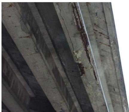
Rys. 3.86. Ubytki betonu, rysy i pęknięcia podłużne w pasie dolnym dźwigara, korozja stali sprężającej
