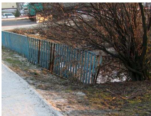
Rys. 5.9. Zniszczenie powłoki antykorozyjnej, korozja, deformacja i przemieszczenie balustrady
