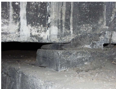
Rys. 3.103. Łożysko elastomerowe uszkodzone na skutek działania wysokiej temperatury - pożaru pod mostem. Odkształcenia postaciowe dyskwalifikują jego przydatność użytkową
