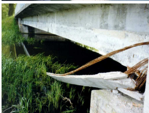
Rys. 3.156. Całkowite uszkodzenie cięgien sprężenia zewnętrznego
