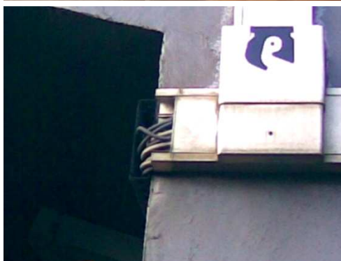
Rys. 4.63. Uszkodzenia osłon kabli energetycznych
