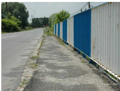
Rys. 3.22. Brak spadku umożliwiającego odpływ wody, wegetacja roślin i miejscowe zanieczyszczenia
