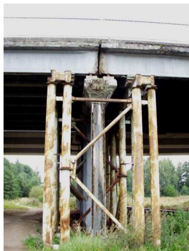
Rys. 3.129. Podpora tymczasowa wzmacniająca osłabiony filar żelbetowy
