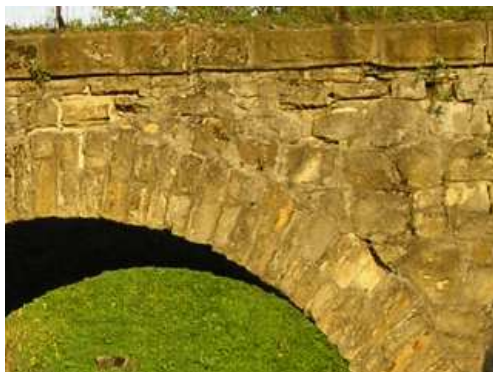
Rys. 3.73. Ubytki materiału ściany bocznej
