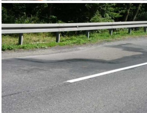
Rys. 5.4. Obniżenie nawierzchni jezdni nad przepustem o około 50 mm
