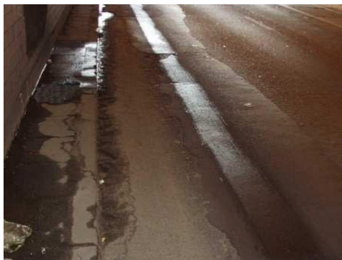
Rys. 4.10. Zanieczyszczenia i zastoiska wody na poboczu technicznym wyniesionym
