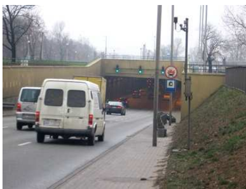
Rys. 4.2. Skarpy przy wjeździe do tunelu właściwie zabezpieczone i utrzymane
