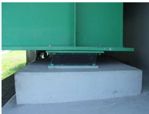
Rys. 3.102. Łożysko elastomerowe w dobrym stanie, położenie prawidłowe - fotografię wykonano w okresie wysokich temperatur (lipiec, temperatura otoczenia +25°C)
