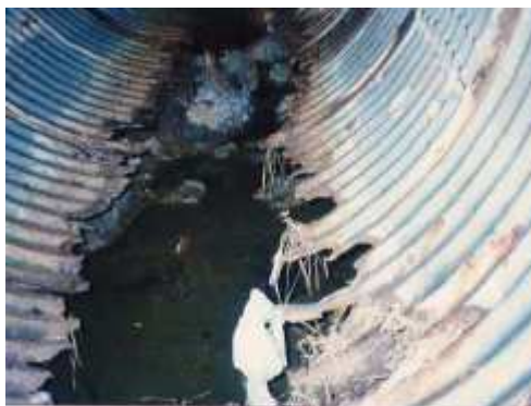
Rys. 5.30. Korozja perforacyjna przepustu stalowego - brak materiału w dolnej strefie przewodu
