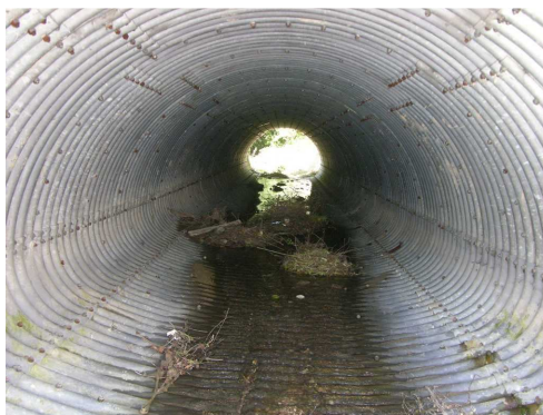
Rys. 5.29. Niewielkie zanieczyszczenia przepustu stalowego - konstrukcji podatnej z blach falistych
