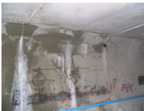
Rys. 4.44. Rozległe przecieki świadczące o nieskutecznej izolacji
