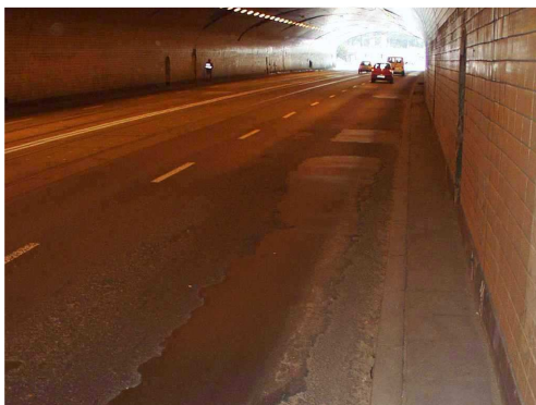
Rys. 4.6. Niewielkie zanieczyszczenia, deformacje do 10 mm
