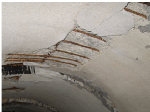
Rys. 5.27. Ubytki betonu, korozja zbrojenia
