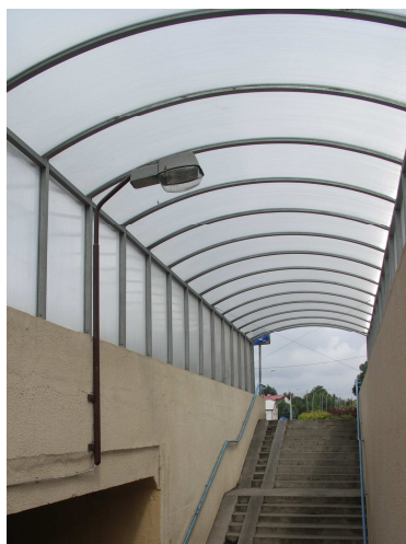
Rys. 4.12. Osłona nad wejściem do przejścia podziemnego w dobrym stanie technicznym
