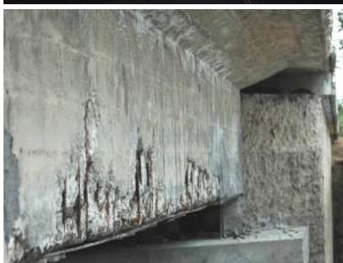
Rys. 3.80. Osady i białe wykwyty, ubytki betonu, odsłonięte pręty zbrojeniowe, korozja zbrojenia
