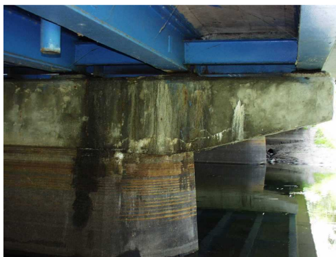
Rys. 3.124. Korozja betonu, zacieki, wykwiły, osady; rysy o rozwarości do 0.3 mm; miejscowa korozja zbrojenia
