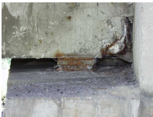
Rys. 3.104. Łożysko stalowe styczne, powierzchniowo skorodowane i zanieczyszczone
