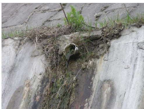
Rys. 6.31. Zanieczyszczona, zbyt krótka rura odwadniająca, częściowo ograniczająca przepływ wody; intensywna korozja
