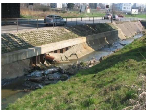
Rys. 6.29. Widoczne uszkodzenie obudowy z płyt żelbetowych. Stalowy korpus konstrukcji nie jest uszkodzony
