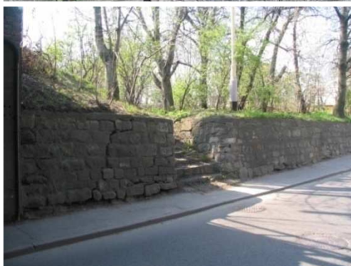
Rys. 6.23. Pęknięcie korpusu konstrukcji i przemieszczenie części elementów
