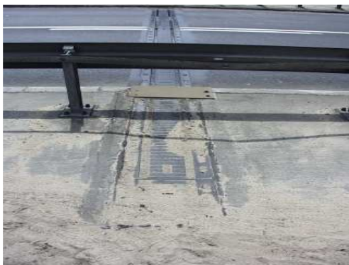
Rys. 3.108. Zanieczyszczone urządzenie dylatacyjne, niewykazujące oznak nieuszczelności
