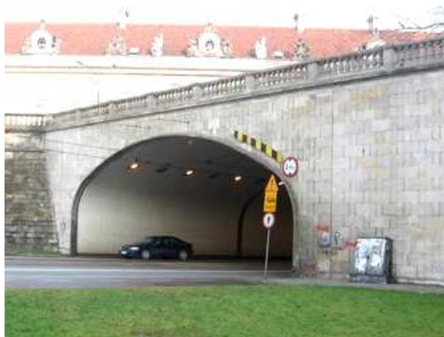
Rys. 4.16. Ściana czołowa w dobrym stanie technicznym, nieliczne zanieczyszczenia i wykwit
