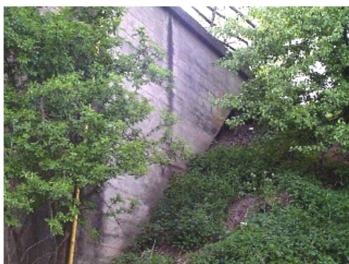
Rys. 3.2. Bujna roślinność zagrażająca trwałości stożków. Osunięcie stożka nasypu spowodowało odsłonięcie skrzydełka, co zagraża m.in. trwałości i stateczności podpory
