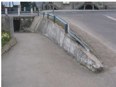
Rys. 6.8. Zdeformowana bariera, uszkodzone połączenie bariery ze słupkami
