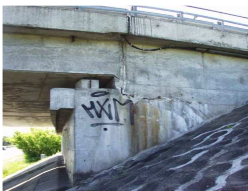
Rys. 3.88. Przemieszczenie przęsła powodujące całkowity zanik szczeliny dylatacyjnej; brak możliwości swobodnego wydłużania przęsła
