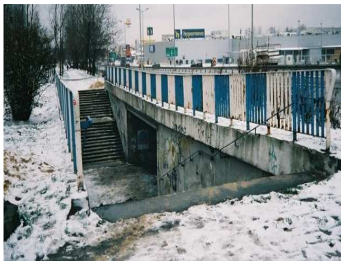
Rys. 4.14. Korozja balustrady wpływająca na estetykę i trwałość
