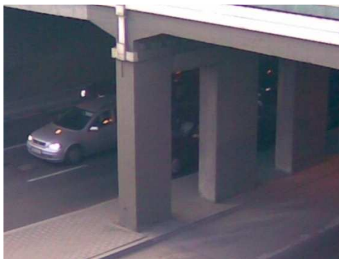
Rys. 4.28. Podpory w tunelu w stanie dobrym
