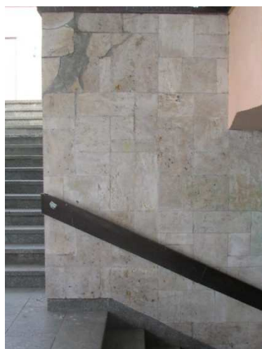
Rys. 4.37. Występujące na ścianie tunelu ubytki okładziny kamiennej uzupełnione zaprawą, pogorszona estetyka obiektu
