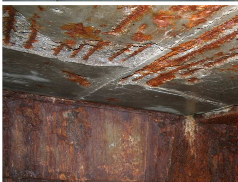
Rys. 3.62. Korozja i ubytki betonu; korozja zbrojenia obejmująca ok. 20% powierzchni pomostu. Przekrój prętów zbrojeniowych uległ zmniejszeniu o ok. 20%.
