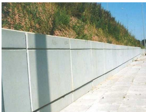
Rys. 6.25. Przemieszczenia poszczególnych elementów niewpływające na stateczność konstrukcji
