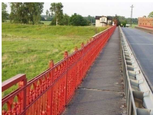
Rys. 3.36. Brak poręczy na długości 6 m, tj. ok. 5% długości balustrady
