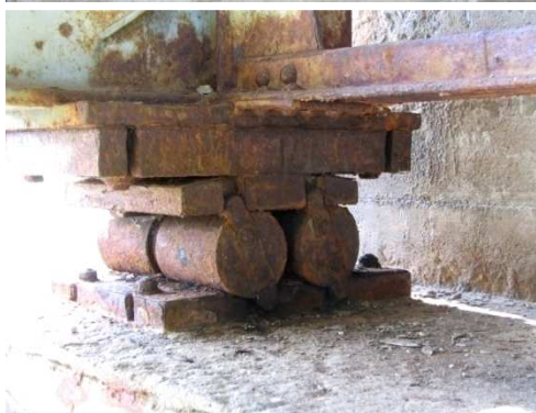
Rys. 3.105. Łożysko stalowe wałkowe skorodowane oraz zanieczyszczone, ruch łożyska utrudniony, widoczne nieprawidłowe położenie łożyska - fotografię wykonano w okresie wysokich temperatur
