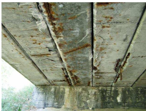
Rys. 3.81. Ubytki betonu, korozja betonu, korozja odsłoniętych prętów zbrojeniowych Kod uszkodzenia: UB, KB, OB, KZ, CB
