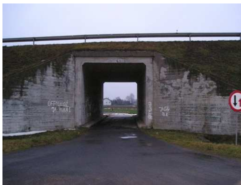
Rys. 4.34. Zanieczyszczenia (graffiti), przecieki wody oraz wykwity świadczące o korozji ługującej występujące na konstrukcji oporowej
