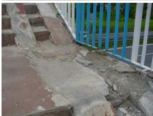
Rys. 3.166. Zniszczenie nawierzchni i uszkodzenie materiału konstrukcyjnego schodów oraz pochylni
