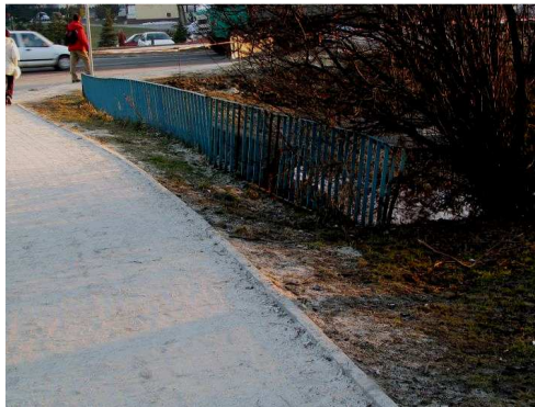
Rys. 5.5. Zanieczyszczenia chodnika nad przepustem
