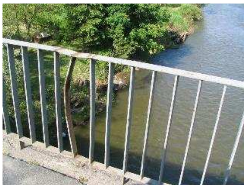
Rys. 3.33. Deformacja szczebliny, zniszczenie powłoki malarskiej. Uszkodzenia nie powodują bezpośredniego zagrożenia bezpieczeństwa użytkowników
