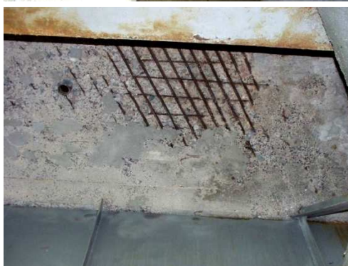
Rys. 3.61. Ubytki betonu i korozja zbrojenia na ok. 10% powierzchni płyty pomostu
