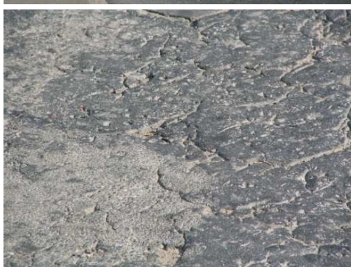
Rys. 3.19. Pęknięcia siatkowe z wykruszeniami występujące na ok. 50% powierzchni jezdni
