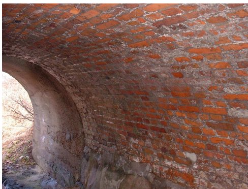
Rys. 5.17. Osady i wykwyty oraz niewielkie ubytki materiału konstrukcji
