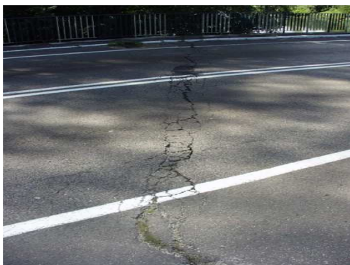
Rys. 3.113. Spękania i ubytki uciąglenia nawierzchni. Na przycółku widoczne są intensywne przecieki
