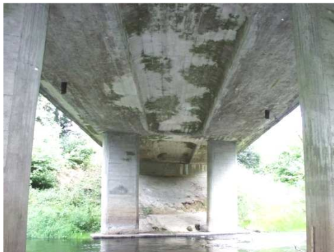
Rys. 3.64. Wykwity, osady, zacieki na ponad 30% powierzchni pomostu, wegetacja roślin (mech)
