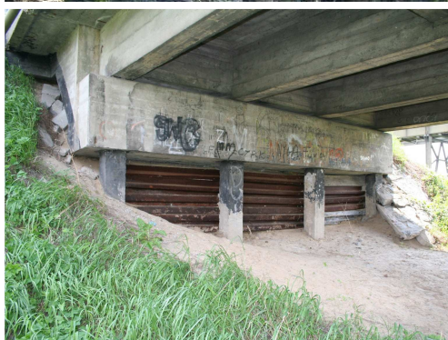
Rys. 3.5. Przemieszczenie i ubytki nasypu powodujące odsłonięcie fundamentu, zagrożenie nośności i stateczności przyczółka
