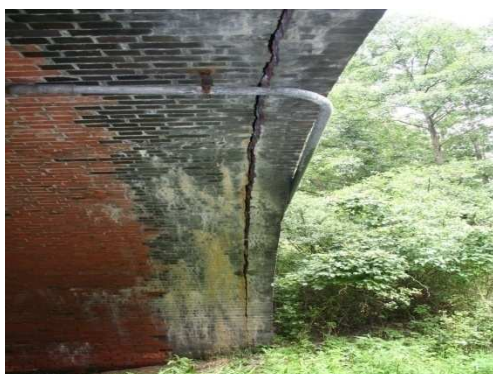
Rys. 3.75. Przemieszczenie poziome ściany bocznej i pęknięcie dźwigara - sklepienia ceglanego. Występuje zagrożenie trwałości i nośności pomostu
