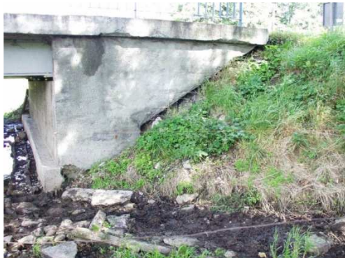
Rys. 3.3. Osunięcie stożka nasypu powodujące odsłonięcie skrzydełka oraz zagrażające trwałości i stateczności podpory
