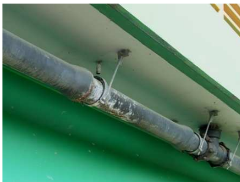
Rys. 3.48. Korozja żeliwnego przewodu zbiorczego spowodowana złym odprowadzeniem wody z sączka
