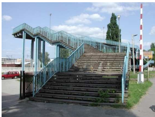
Rys. 3.164. Zniszczenie powłoki malarskiej na ok. 10% powierzchni balustrady i początku korozji materiału
