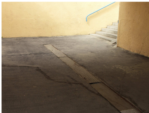
Rys. 4.8. Niewielkie zanieczyszczenia i nierówności nawierzchni w przejściu podziemnym
