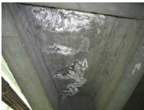
Rys. 3.57. Przecieki na spodzie płyty pomostu świadczące o braku skuteczności izolacji
