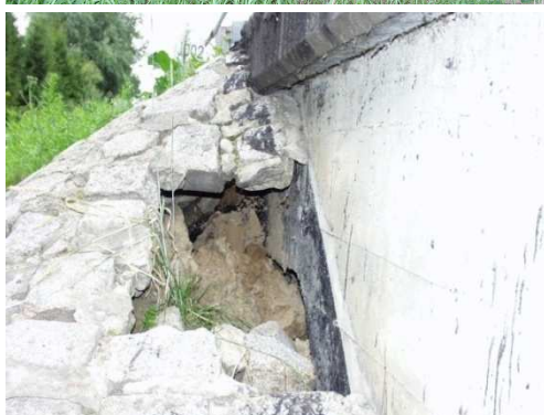
Rys. 3.6. Osunięcie nasypu i jego obudowy. Uszkodzenie spowodowało częściowe odsłonięcie skrzydełka oraz zagraża m.in. trwałości i stateczności przyczółka
