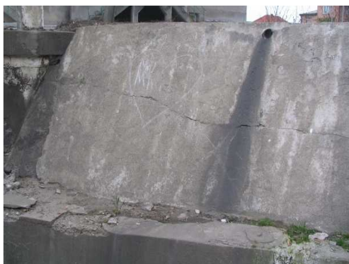
Rys. 6.13. Poziome pęknięcie korpusu powstałe w miejscu przerwy w betonowaniu konstrukcji. Nie jest spowodowane przemieszczeniem ściany, nie zaobserwowano wycieków ze szczeliny
