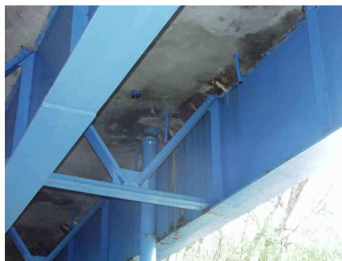
Rys. 3.54. Lokalne przecieki w sąsiedztwie wpustu i sączków - powierzchnia przecieków nieprzekraczająca 5% powierzchni płyty pomostu
