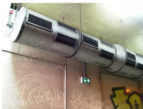
Rys. 4.51. Sprawnie działające urządzenia wentylacyjne
