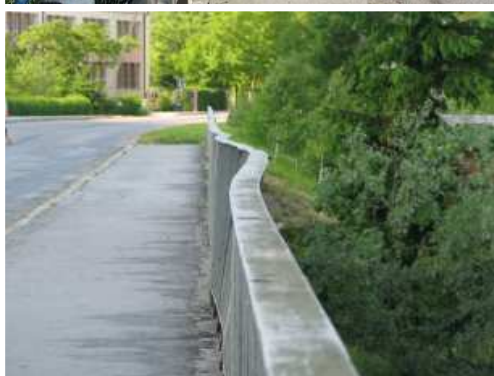
Rys. 3.35. Deformacja o wielkości od 10 do 15 cm w stosunku do pierwotnego położenia. Stwierdzono również osłabienie zamocowania balustrady do pomostu
