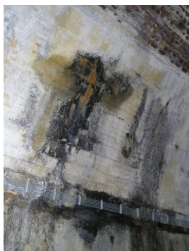
Rys. 4.22. Przepieki, ubytki oraz korozja materiału, osady na ścianie obudowy z cegły
