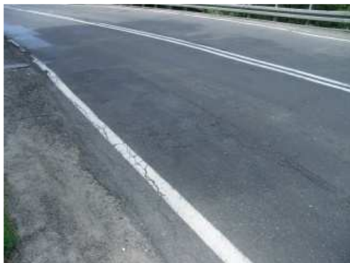
Rys. 3.10. Nawierzchnia na dojazdach obniżona o ok. 15 mm. Występują również lokalne spękania i ubytki asfaltu
