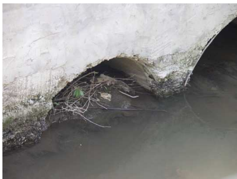
Rys. 5.26. Zanieczyszczenia przewodu powyżej 30% powierzchni przekroju
