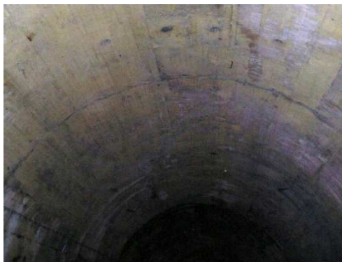
Rys. 4.25. Wykwity na sklepieniu betonowym świadczące o korozji ługującej
