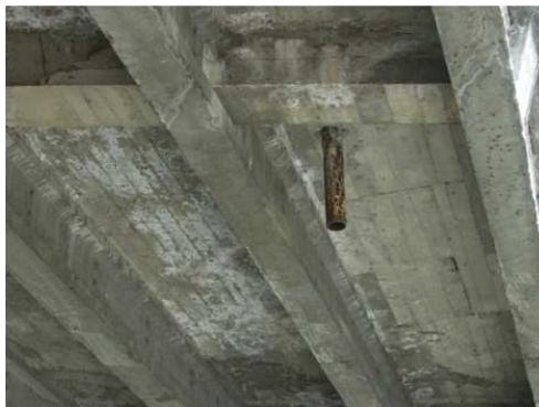
Rys. 3.63. Przekięty wody przez płytę pomostu, zacieki i wykwyty na ok. 50% powierzchni pomostu, świadczące o korozji ługującej betonu, ubytki betonu
