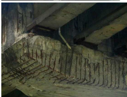
Rys. 3.125. Ubytki betonu oczepu oraz korozja zbrojenia stwarzające zagrożenie dla bezpieczeństwa konstrukcji
