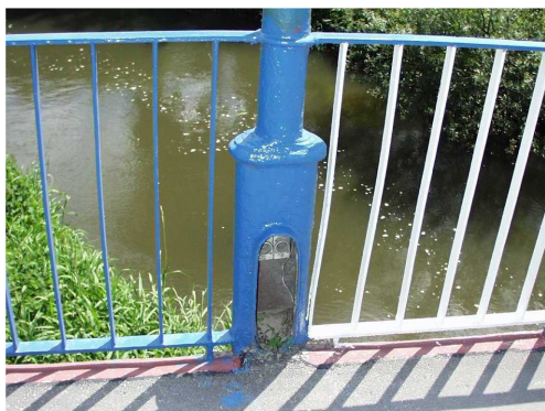
Rys. 3.159. Zniszczenie osłony instalacji elektrycznej w latarni oświetlającej obiekt
