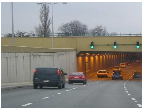
Rys. 4.32. Niewielkie (nieprzekraczające 5% powierzchni) przecieki wody na ścianie oporowej
