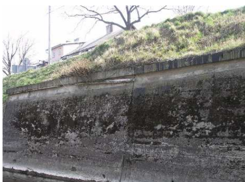
Rys. 6.38. Niezadawalająca estetyka gzymsu
