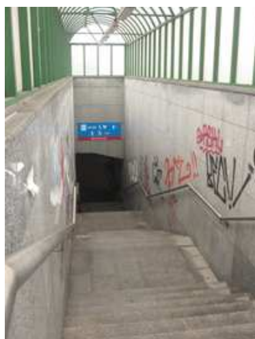
Rys. 4.40. Na ścianach przy wejściu do tunelu występują zanieczyszczenia (graffiti), pogorszona jest estetyka obiektu
