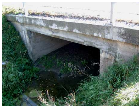
Rys. 5.23. Zanieczyszczona płyta denna - utrudniony przepływ wody
