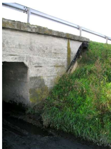
Rys. 4.4. Przemieszczenia i osiadanie gruntu skarpy powodujące odsłonięcie ściany czołowej
