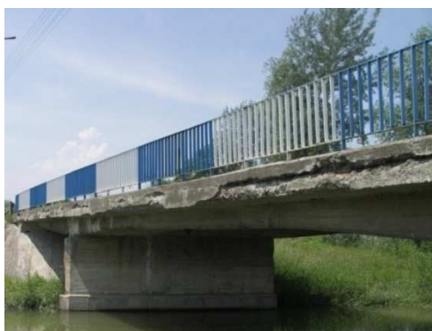
Rys. 3.41. Ubytki betonu na ok. 25% powierzchni belek podporęczowych; odsłonięte, skorodowane zbrojenie, zacieki i wykwity świadczące o korozji betonu
