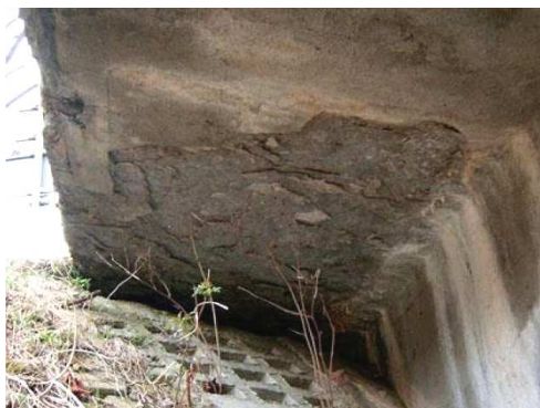
Rys. 3.66. Osady i wykwyty świadczące o korozji betonu, ubytki betonu
