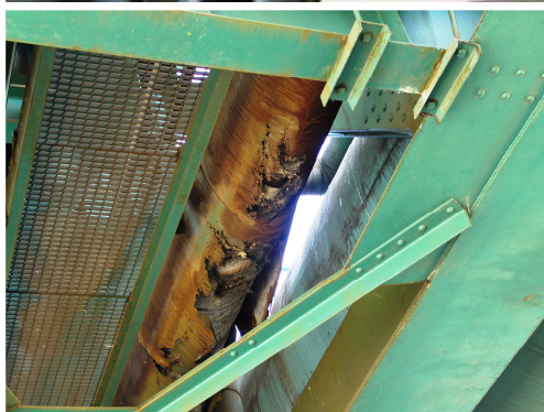
Rys. 3.161. Korozja perforacyjna osłony i ubytki izolacji ciepłociągu
