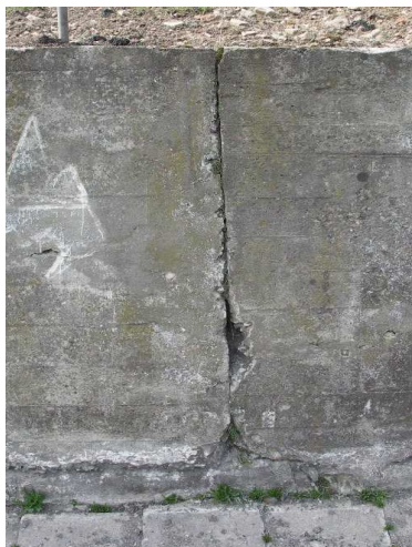
Rys. 6.36. Nieliczne ubytki betonu w otoczeniu szczeliny dylatacyjnej pogarszające estetykę konstrukcji
