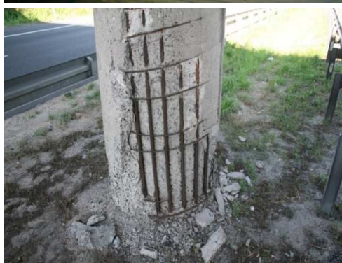
Rys. 3.126. Ubytki betonu filara oraz korozja zbrojenia stwarzające zagrożenie dla bezpieczeństwa konstrukcji
