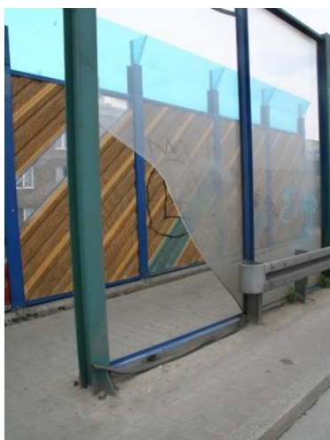
Rys. 3.147. Uszkodzony panel ekranu akustycznego, estetyka ekranu niezadawalająca - graffiti
