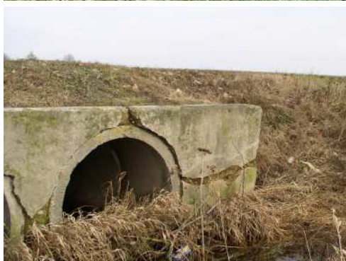
Rys. 5.39. Rysy i pęknięcia głowicy, przemieszczenie fragmentu głowicy wlotowej
