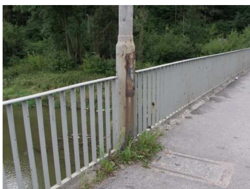
Rys. 3.158. Zniszczenie zabezpieczenia antykorozyjnego i korozja latarni oświetlającej obiekt
