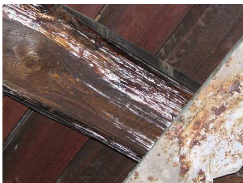
Rys. 3.71. Zawilgocenia oraz powierzchniowa korozja poprzecznic
