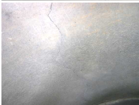
Rys. 5.28. Rysa równoległa do osi przepustu - wskazany przegląd szczegółowy lub ekspertyza
