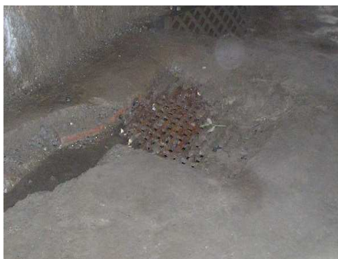
Rys. 4.41. Kratka ściekowa jest zanieczyszczona, częściowo niedrożna
