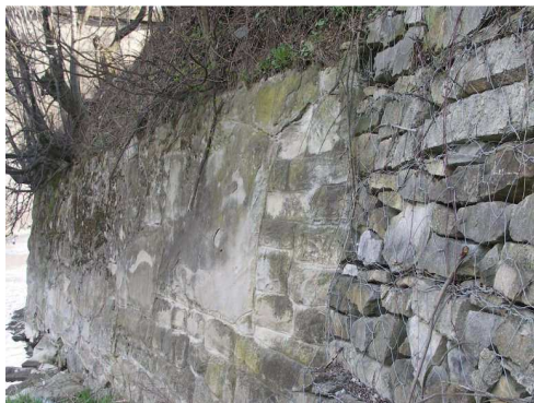
Rys. 6.2. Drzewa rosnące bezpośrednio nad konstrukcją oporową zagrażające jej trwałości
