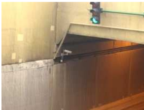
Rys. 4.62. Prawidłowo zabezpieczone i utrzymane urządzenia obce (przewody telekomunikacyjne)
