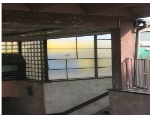
Rys. 4.29. Niewielkie (nieprzekraczające 5% powierzchni) zacieki i wykwyty na podporze świadczące o rozwijającej się korozji ługującej
