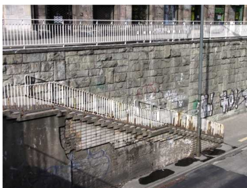
Rys. 6.42. Korozja balustrad, korozja i ubytki okładziny schodów
