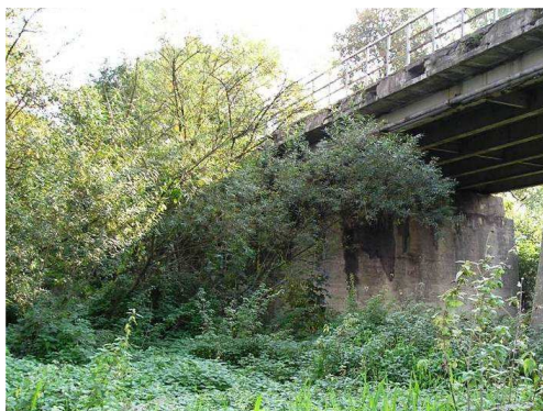
Rys. 3.1. Wegetacja roślin (drzew, krzewów) występująca na ponad 30% powierzchni nasypów, zagrażająca trwałości stożków
