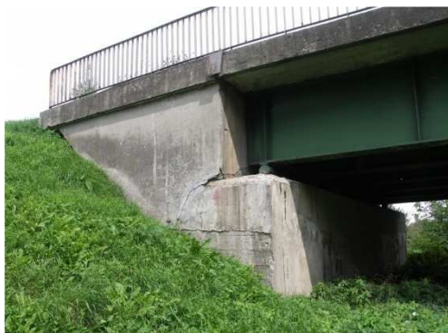
Rys. 3.118. Pęknięcie skrzydła na skutek osunięcia stożka i zanieczyszczenia szczeliny dylatacyjnej
