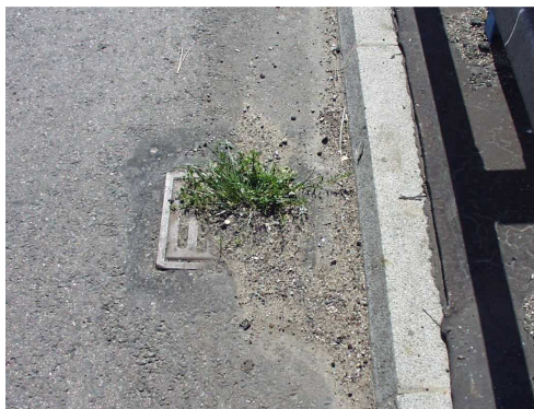
Rys. 3.46. Zanieczyszczenie powodujące całkowitą niedrożność odwodnienia
