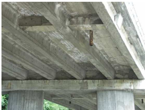
Rys. 3.56. Rozległe przecieki świadczące o braku szczelności izolacji
