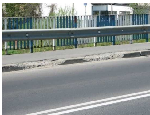
Rys. 5.7. Uszkodzenie ok. 50% krawężników nad przepustem
