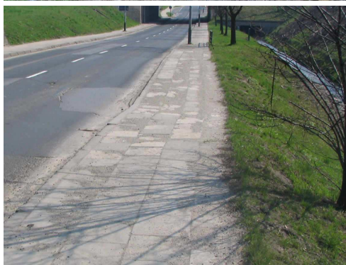
Rys. 6.3. Zapadnięcie jezdni i poziome przesunięcie chodnika nad konstrukcją oporową z koszy siatkowych
