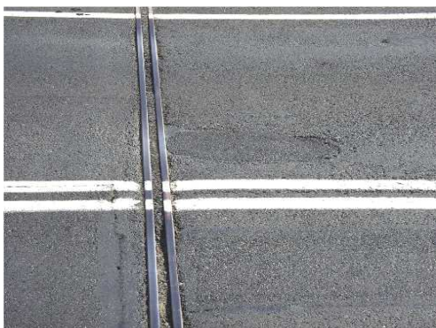
Rys. 3.110. Zanieczyszczenie urządzenia dylatacyjnego ograniczające przesuw przęsła; nierówności i spękania nawierzchni w bezpośrednim sąsiedztwie urządzenia
