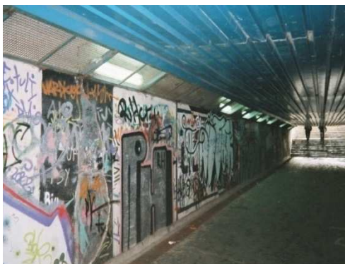
Rys. 4.49. Część elementów oświetlenia uszkodzona i niesprawna
