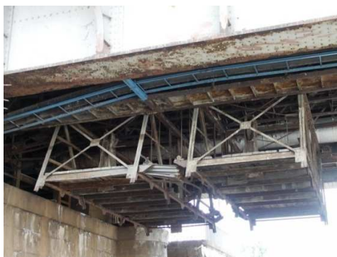
Rys. 3.172. Zniszczenie powłoki antykorozyjnej, korozja elementów wózka rewizyjnego, uszkodzenie drewnianych elementów pomostu wózka, zablokowanie ruchu
