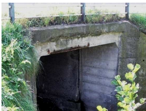
Rys. 5.34. Miejscowe ubytki betonu i korozja zbrojenia
