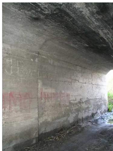
Rys. 4.45. Niewielkie przecieki na stropie tunelu
