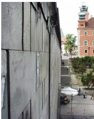
Rys. 4.19. Przemieszczenie głowicy ściany czołowej o ok. 50 mm przy wysokości ściany 7 m
