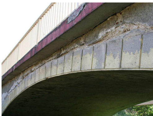
Rys. 3.74. Korozja i ubytki materiału ściany bocznej mostu sklepionego; wspornik podchodnikowy z niewielkimi zanieczyszczeniami
