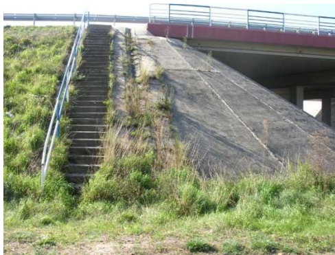
Rys. 3.52. Zanieczyszczenie ścieku na skar- pie, wegetacja roślin
