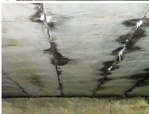
Rys. 3.58. Przecieki pomiędzy belkami prefabrykowanymi mostu płytowego
