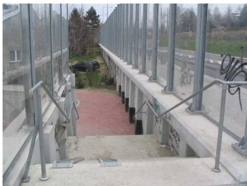
Rys. 6.9. Zanieczyszczenia (graffiti) widoczne na ekranie akustycznym
