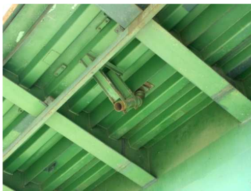
Rys. 3.67. Miejscowe zniszczenie powłoki antykorozyjnej
