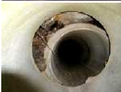
Rys. 5.32. Przemieszczenie sąsiednich elementów przepustu rurowego; zmniejszenie światła o ok. 20%
