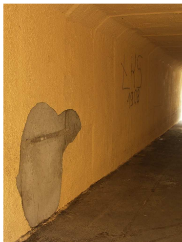
Rys. 4.21. Zanieczyszczenia, ubytki tynku spowodowane złym wykonawstwem
