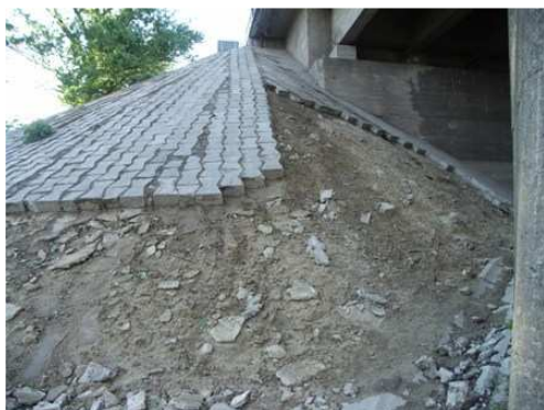
Rys. 3.7. Brak ok. 50% elementów betonowych umacniających stożek
