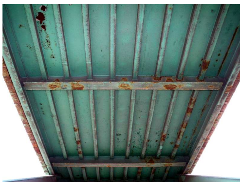
Rys. 3.68. Zniszczenie powłoki antykorozyjnej i miejscowa korozja pomostu
