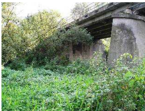
Rys. 3.135. Bujna roślinność ograniczająca swobodny przepływ wielkiej wody i przewietrzanie ustroju. W zimie utrudniony będzie spływ kry lodowej
