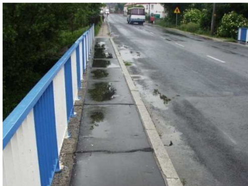
Rys. 3.23. Brak spadku umożliwiającego odpływ wody, widoczne liczne zastoiska; brak spoin między belką podporęczową i krawężnikiem a nawierzchnią chodnika
