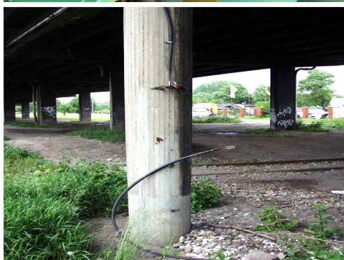
Rys. 3.162. Uszkodzenie instalacji uszyniecia obiektu
