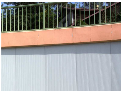
Rys. 6.39. Rysy skurczowe obejmujące ok. 20% powierzchni gzymsu
