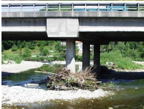
Rys. 3.132. Zanieczyszczenia gromadzące się przy filarze utrudniające spływ wody (i kry lodowej)
