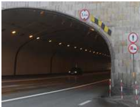
Rys. 4.47. Elementy oświetlenia w dobrym stanie technicznym i odpowiednio utrzymane
