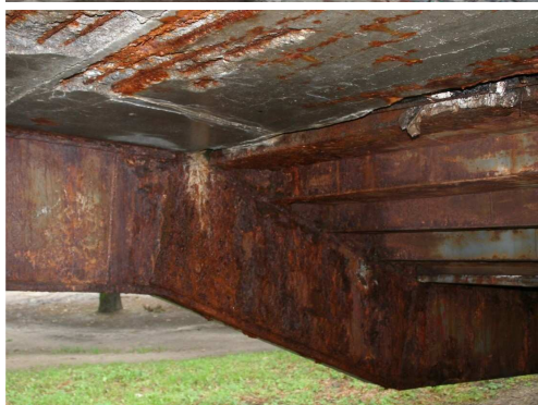
Rys. 3.167. Silnie zaawansowana korozja stali konstrukcyjnej, betonu i stali zbrojeniowej, osłabienie przekroju
