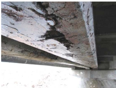
Rys. 3.82. Zaawansowana korozja betonu i stali zbrojeniowej, ubytki betonu, rysy i pęknięcia podłużne o rozwarości powyżej 1 mm na 20% powierzchni dźwigarów
