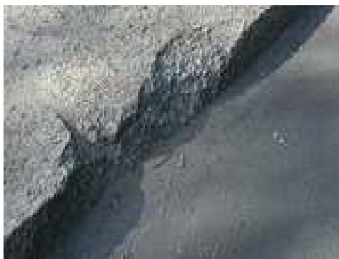
Rys. 4.9. Ubytki betonu krawężnika
