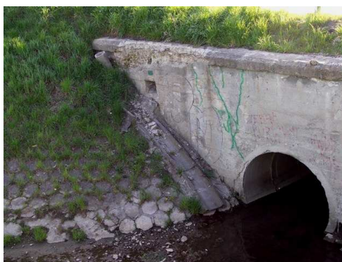
Rys. 5.11. Ubytki betonu gzymsu, odsłonięte, skorodowane zbrojenie
