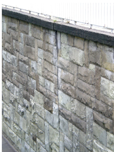
Rys. 6.35. Szczelina dylatacyjna bez uszkodzeń
