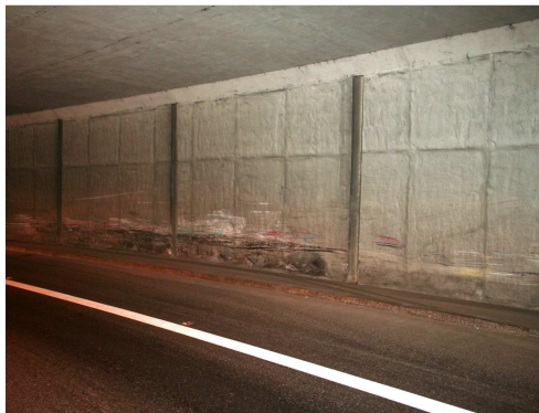
Rys. 4.20. Zanieczyszczenia, otarcia i niewielkie ubytki betonu ściany tunelu nie wpływające na trwałość
