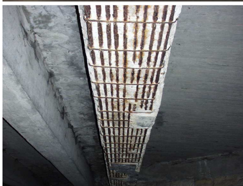
Rys. 3.84. Ubytki betonu, korozja prętów zbrojeniowych powodująca zmniejszenie ich przekroju o ok. 20%
