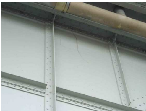
Rys. 3.95. Pęknięcie środnika dźwigara blachownicowego
