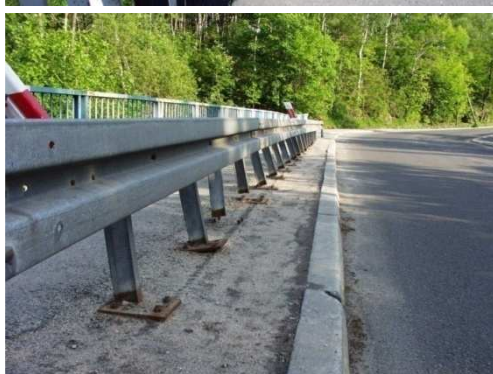
Rys. 3.39. Przemieszczenie bariery, uszkodzenie połączenia słupków z pomostem na odcinku 30 m, tj. na ok. 30% długości bariery
