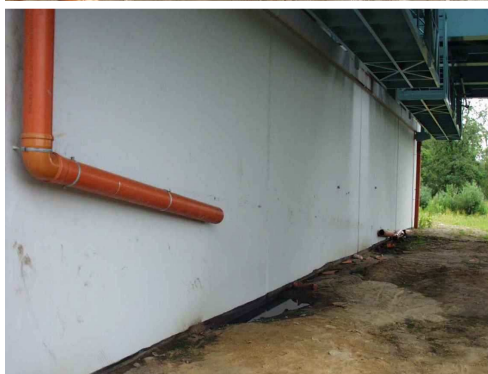
Rys. 3.50. Brak elementów systemu odwodnienia
