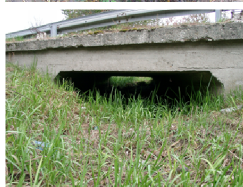
Rys. 5.43. Zanieczyszczenia koryta cieką (zamulenie) zmniejszające światło przepustu o ok. 75% i utrudniające przepływ wody
