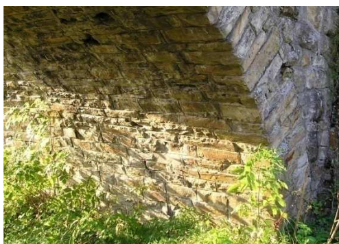
Rys. 3.101. Złuszczenia i ubytki elementów kamiennych, z których wykonano sklepienie. Ubytki nie przekraczają 5% powierzchni przekroju sklepienia
