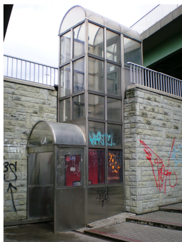
Rys. 4.65. Zanieczyszczenia obudowy szybu windy (graffiti) w przejściu podziemnym
