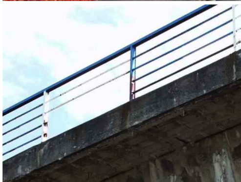
Rys. 3.37. Brak przeciągów balustrady
