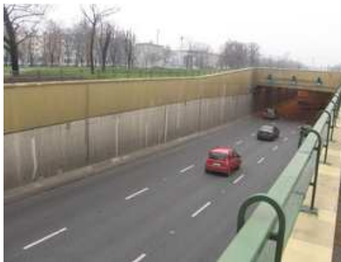
Rys. 4.13. Balustrada na konstrukcji oporowej przy wjeździe do tunelu w dobrym stanie technicznym
