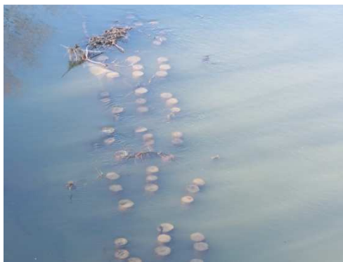
Rys. 3.137. Zbyt wysoko obcięte pale starej podpory w sąsiedztwie nowego mostu ułatwiają gromadzenie się zanieczyszczeń i utrudniają spływ wody i lodu
