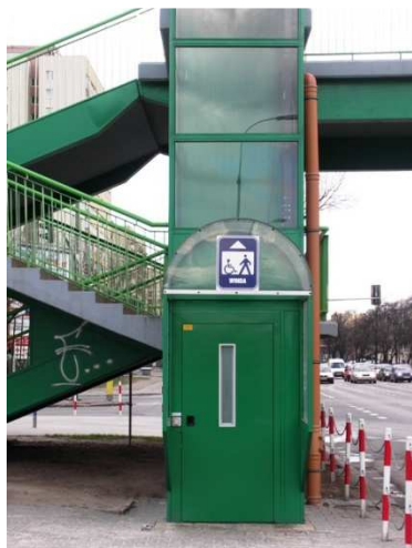
Rys. 3.168. Winda sprawna - bez widocznych uszkodzeń zewnętrznych
