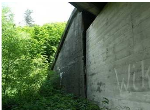
Rys. 3.145. Przemieszczenie korony skrzydła o ok. 60 mm, objawy korozji ługującej
