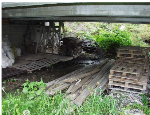
Rys. 3.134. Zgromadzone pod mostem materiały zagrażające trwałości i bezpieczeństwu konstrukcji (pożar)
