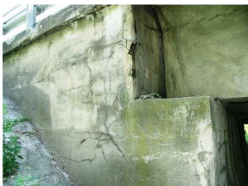
Rys. 3.120. Zarysowanie powierzchni korpusu i skrzydła, korozja i ubytki betonu
