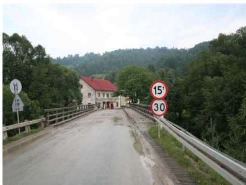
Rys. 7.3. Zły stan techniczny obiektu, zbyt mała nośność i ograniczenie prędkości
