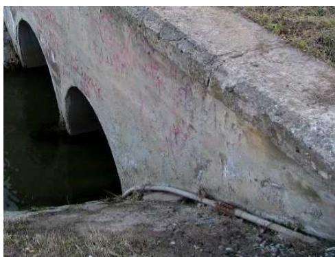
Rys. 5.44. Uszkodzenia osłony i zamocowania kabla telekomunikacyjnego
