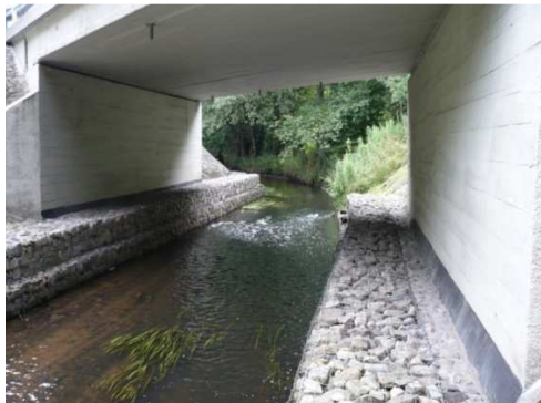
Rys. 3.130. Koryto rzeki i przestrzeń podmostowa - bez zastrzeżeń
