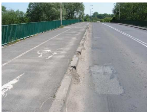
Rys. 3.26. Krawężnik zniszczony w ok. 25%; zbyt małe spadki poprzeczne na chodniku i ścieżce rowerowej
