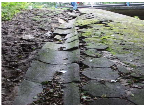
Rys. 3.53. Przemieszczenie i zniszczenie elementów prefabrykowanych ścieku na skarpie, ubytki i zanieczyszczenia betonu
