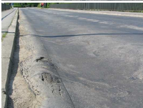
Rys. 3.17. Deformacje nawierzchni (koleiny) o głębokości przekraczającej 60 mm, rysy i pęknięcia asfaltu, zanieczyszczenia
