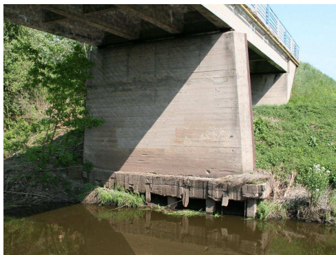
Rys. 3.128. Częściowe podmycie fundamentu filara
