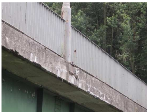
Rys. 3.40. Wykwity, wylugowania, stalaktity na betonie. Uszkodzenia występują na ok. 20% powierzchni gzymsów. Niewielkie ubytki betonu
