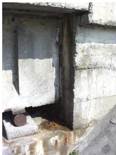
Rys. 3.89. Element (deska) w szczelinie dylatacyjnej, między dźwigarem a ścianką żwirową, uniemożliwiający swobodne wydłużanie przęsła
