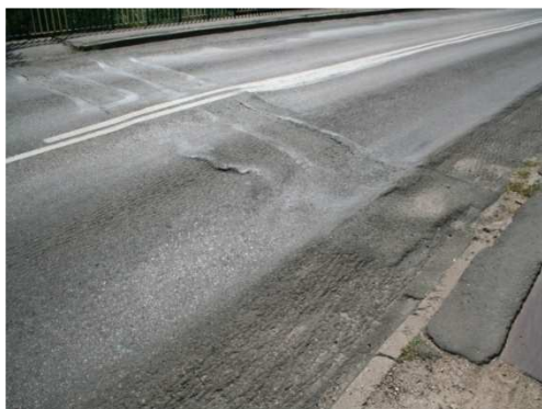
Rys. 3.11. Deformacje nawierzchni na dojazdach - koleiny o głębokości do 30 mm
