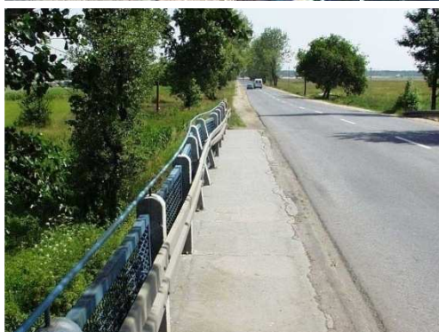
Rys. 3.34. Deformacja oraz przemieszczenie balustrady wraz z prowadnicą o ok. 15 cm. Zamocowanie 2 słupków zostało osłabione
