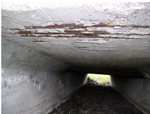
Rys. 5.18. Widoczne ubytki betonu i korozja zbrojenia w płycie górnej przepustu ramownicowego
