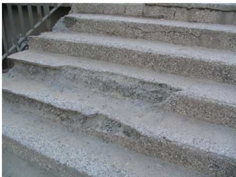
Rys. 4.55. Ubytki oraz pęknięcia betonu na schodach do przejścia podziemnego
