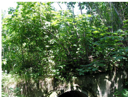
Rys. 5.2. Bujna wegetacja na skarpie zagrażająca jej trwałości
