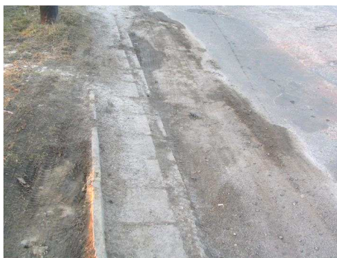
Rys. 5.3. Zanieczyszczenia jezdni nad przepustem utrudniające przepływ wody; widoczne ubytki krawężnika
