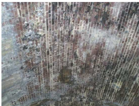
Rys. 4.26. Przecieki, wykwity i osady na sklepieniu z cegły świadczące o korozji materiału oraz ubytki
