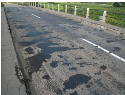
Rys. 3.16. Brak spadków umożliwiających odprowadzenie wody, łaty i miejscowe nierówności nieprzekraczające 10 mm
