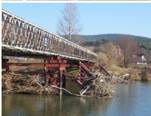
Rys. 3.133. Liczne zanieczyszczenia gromadzące się przy filarach utrudniające spływ wody (i kry lodowej)
