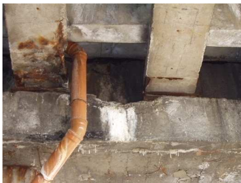
Rys. 3.49. Uszkodzenia wskazujące na niewłaściwe zamocowanie wpustu i/lub rury spustowej. Woda spływająca obok rury spustowej przyspiesza degradację konstrukcji
