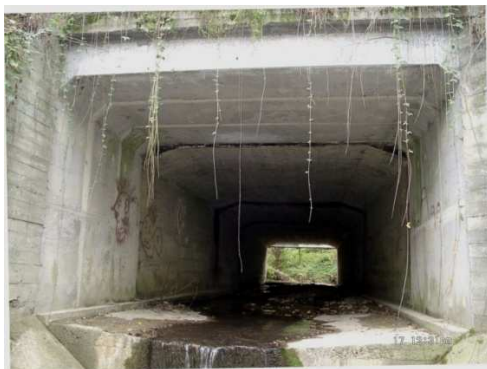
Rys. 5.22. Niewielkie zanieczyszczenia płyty dennej
