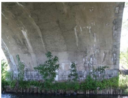
Rys. 3.77. Przecieki przez sklepienie świadczące o braku skuteczności izolacji, osady i wykwyty świadczące o korozji betonu
