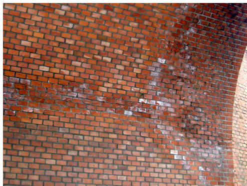
Rys. 3.100. Przecieki wody, powierzchniowe ubytki cegieł i spoin, osady i wykwity na powierzchni sklepienia świadczące o korozji cegieł i ich spoin
