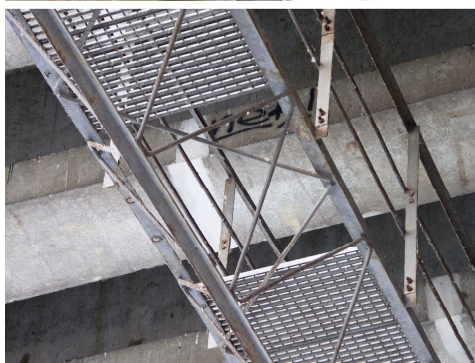
Rys. 3.173. Zniszczenie fragmentu pomostu wózka rewizyjnego
