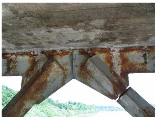
Rys. 3.96. Pęknięcie krzyżulca dźwigara kratownicowego, korozja elementów dźwigara
