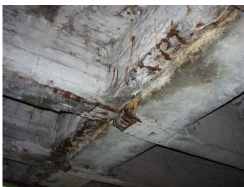
Rys. 3.142. Korozja i ubytki betonu w obrębie przegubu, korozja zbrojenia, zanieczyszczenia szczeliny dylatacyjnej
