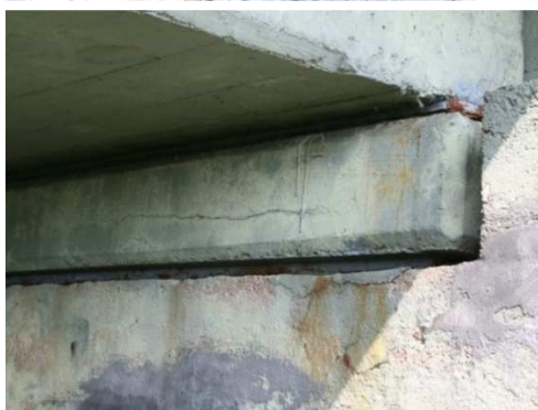
Rys. 3.106. Łożysko betonowe wahaczowe - widoczna pozioma rysa
