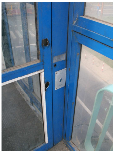
Rys. 3.169. Winda uszkodzona - brak możliwości otwarcia drzwi, winda nie działa
