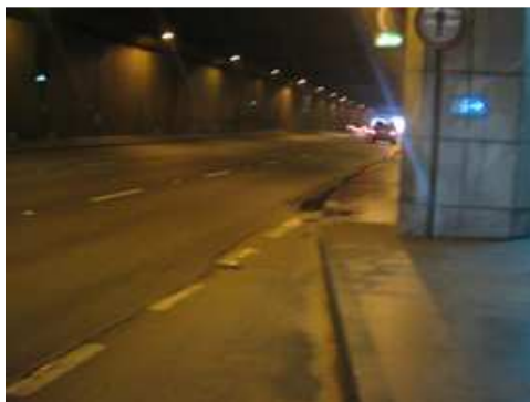
Rys. 4.11. Zanieczyszczenia i zastoiska wody na chodnikach
