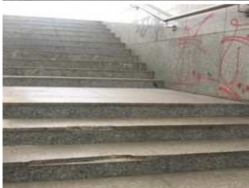
Rys. 4.54. Ubytki okładziny kamiennej na schodach do tunelu
