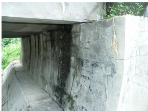
Rys. 3.119. Intensywne zarysowanie ściany czołowej, korozja i ubytki betonu, wegetacja roślin na ławie podłożyskowej, zawilgocenia spowodowane przeciekiem przez urządzenia dylatacyjne
