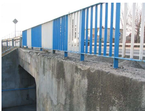
Rys. 4.18. Na ścianie czołowej występują zarysowania betonu, wykwyty świadczące o korozji ługującej na ok. 30% powierzchni oraz ubytki betonu
