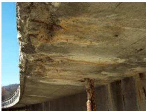
Rys. 3.65. Zacieki i wykwyty świadczące o korozji betonu, ubytki betonu, korozja zbrojenia
