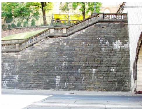
Rys. 4.35. Przecieki, wykwity, korozja i ubytki elementów kamiennych
