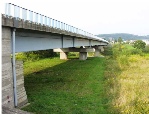
Rys. 3.131. Przestrzeń podmostowa - bez zastrzeżeń
