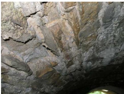
Rys. 5.20. Widoczne ubytki kamienia w sklepieniu przepustu, zniszczenie struktury kamienia, zniszczenie spoin elementów kamiennych
