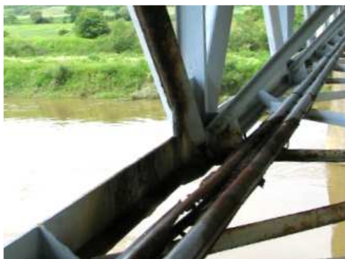
Rys. 3.160. Ubytki korozyjne osłon przewodów telekomunikacyjnych
