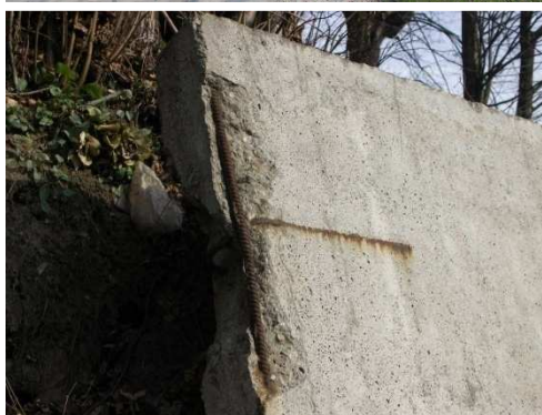
Rys. 6.4. Ubytki gruntu za konstrukcją oporową mające wpływ na stateczność konstrukcji; ubytki betonu i korozja zbrojenia
