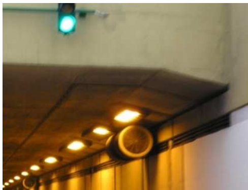
Rys. 4.50. Sprawnie działające urządzenia wentylacyjne
