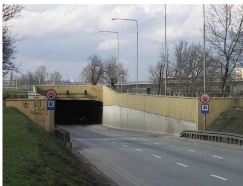
Rys. 4.61. Stan sygnalizacji i oznakowania bez zastrzeżeń
