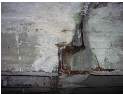
Rys. 3.141. Korozja i ubytki betonu w obrębie przegubu, korozja zbrojenia, zanieczyszczenia szczeliny dylatacyjnej, przecieki wody
