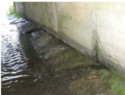
Rys. 5.24. Niewielkie ubytki materiału płyty dennej przepustu sklepionego
