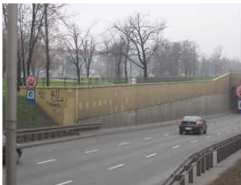
Rys. 4.31. Nieliczne zanieczyszczenia (grafiti) występujące na ścianie oporowej
