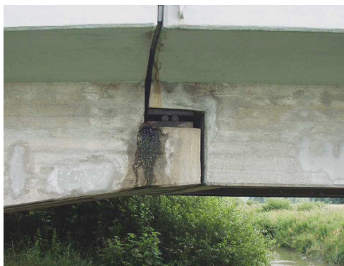
Rys. 3.138. Zanieczyszczony przegub, przecieki wody, beton skorodowany w obrębie przegubu
