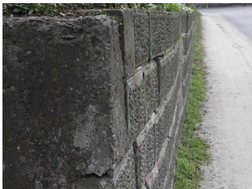
Rys. 6.21. Przemieszczenie elementów konstrukcji niewpływające na trwałość ani stateczność. Wskazane jest wykonanie przeglądu szczegółowego w celu udokumentowania i zinventaryzowania przemieszczeń
