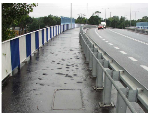
Rys. 3.21. Deformacje nawierzchni bitumicznej do 20 mm na 10% powierzchni chodnika
