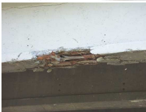
Rys. 3.83. Uszkodzenie skrajnego dźwigara kablobetonowego na skutek uderzenia pojazdu; ubytki betonu, pęknięcie kabli sprężających
