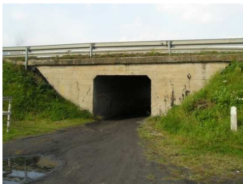
Rys. 4.5. Przemieszczenia i osiadanie gruntu skarpy powodujące odsłonięcie ściany czołowej
