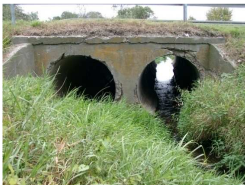
Rys. 5.38. Ubytki betonu i korozja zbrojenia głowicy
