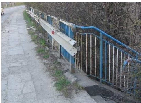
Rys. 6.1. Zanieczyszczenia i wegetacja roślin na chodniku nad konstrukcją oporową
