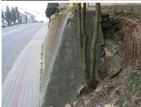
Rys. 6.5. Wypłukanie gruntu, ubytki kamienia - zasypki konstrukcji oporowej. Rosnące drzewa mogą spowodować dodatkowe uszkodzenia konstrukcji oporowej
