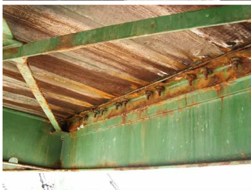
Rys. 3.72. Liczne zawilgocenia i przecieki oraz korozja drewna (gnicie) powodująca zmniejszenie przekroju o około 20%
