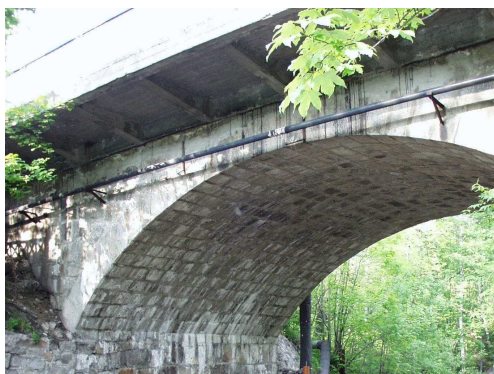
Rys. 3.99. Przecieki wody, osady i wykwity na powierzchni sklepienia świadczące o korozji spoin elementów sklepienia
