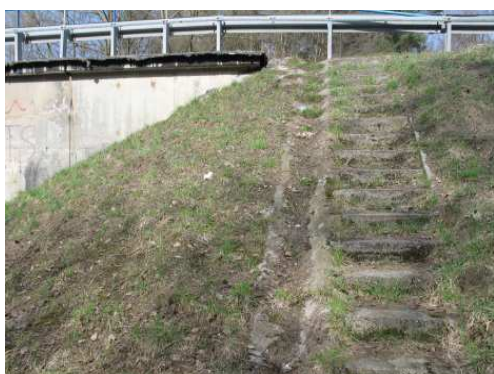
Rys. 3.9. Zanieczyszczenia, wegetacja roślin na schodach dla obsługi, ubytki betonu schodów, brak balustrady
