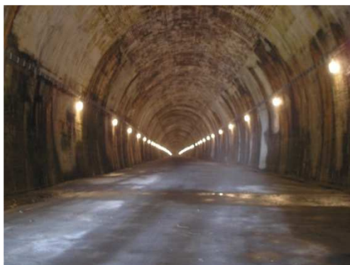
Rys. 4.27. Widoczne zastoiska wody na płycie dennej. Nie stwierdzono przecieków przez strop i ściany obudowy tunelu
