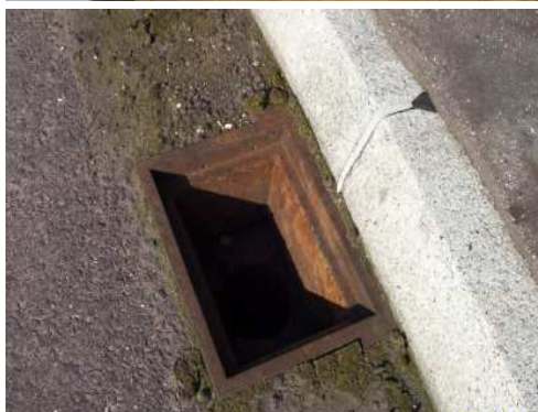
Rys. 3.51. Brak kratki ściekowej wpustu
