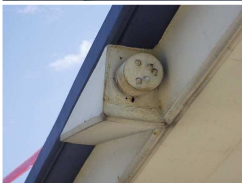
Rys. 3.151. Niewielkie zniszczenie zabezpieczeń antykorozyjnych zakotwienia wanty
