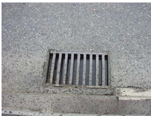
Rys. 3.47. Zanieczyszczenie przewodów odprowadzających wodę powodujące całkowitą niedrożność systemu odwodnienia - brak odpływu wody
