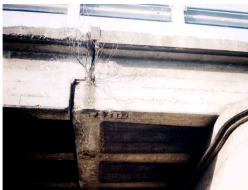
Rys. 3.139. Zanieczyszczony przegub, przecieki, wegetacja roślin i ubytki betonu w strefie oparcia
