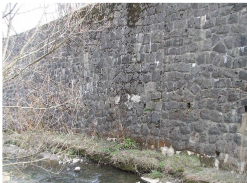
Rys. 6.17. Widoczne osady i wykwyty pojawiające się w spoinach elementów kamiennych; kamień częściowo porośnięty mchem
