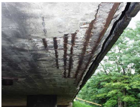
Rys. 3.85. Ubytki betonu, korozja betonu, korozja zbrojenia
