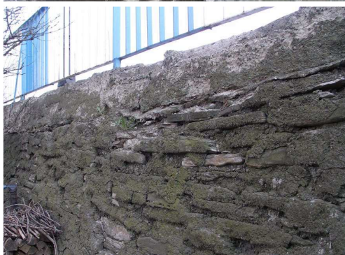
Rys. 6.20. Ubytki materiału konstrukcji, zniszczenie struktury kamienia, zniszczenie spoin elementów kamiennych, wegetacja roślin
