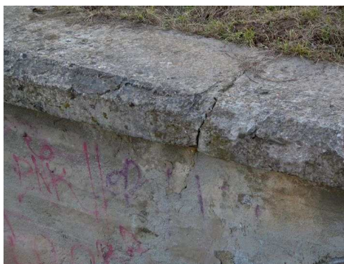
Rys. 5.10. Ubytki betonu, pęknięcia, powierzchniowa korozja betonu, wegetacja roślin (mchy) zagrażające trwałości
