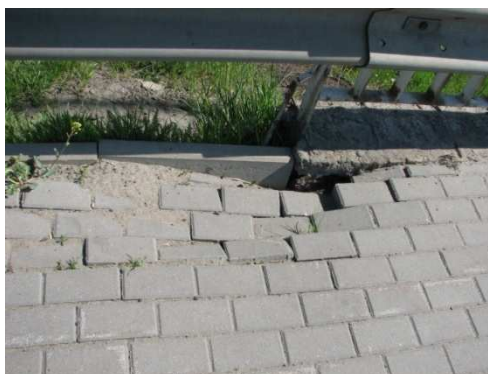
Rys. 5.6. Obniżenie nawierzchni chodnika nad przepustem na skutek wypłukania zasyпки
