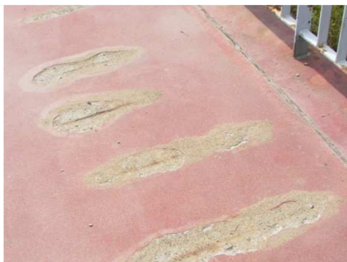
Rys. 3.24. Złuszczenie i ubytki nawierzchni z żywicy epoksydowej; ubytki betonu i korozja zbrojenia pod nawierzchnią
