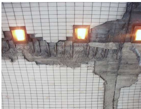
Rys. 4.24. Miejscowe ubytki betonu sklepienia, odsłonięte i skorodowane pręty zbrojeniowe
